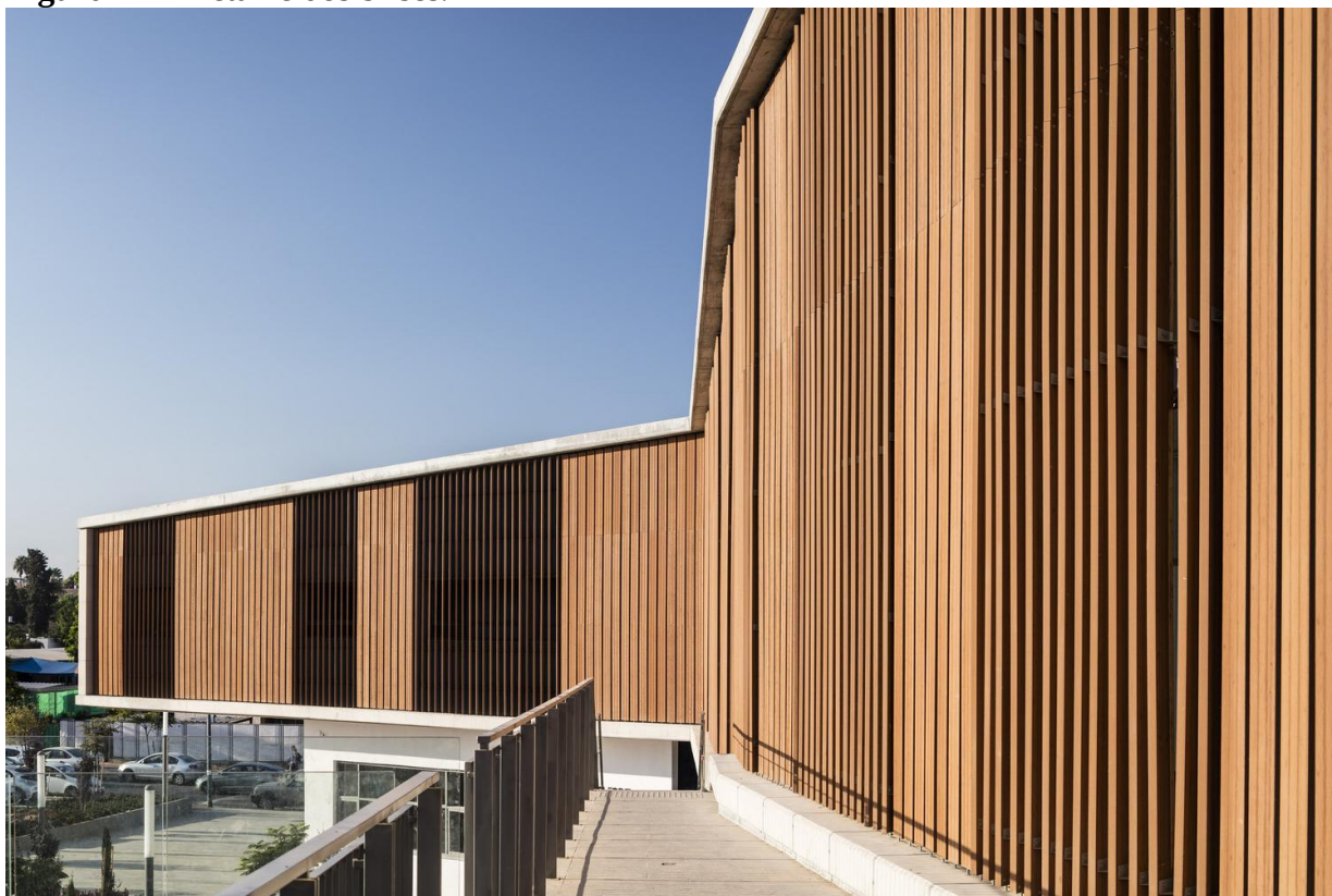
Figura 22 – Detalhe dos brises.
