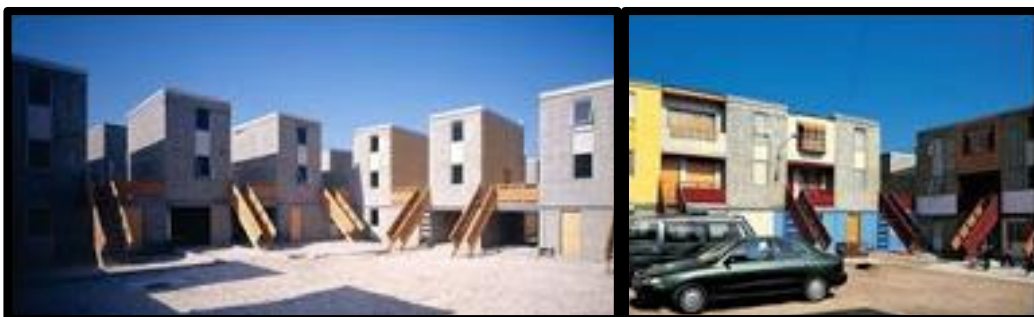
Figura06 – Antes de depois da intervenção dos moradores.
