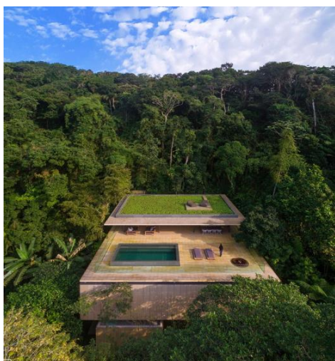
Figura 3 - Telhado verde extensivo
