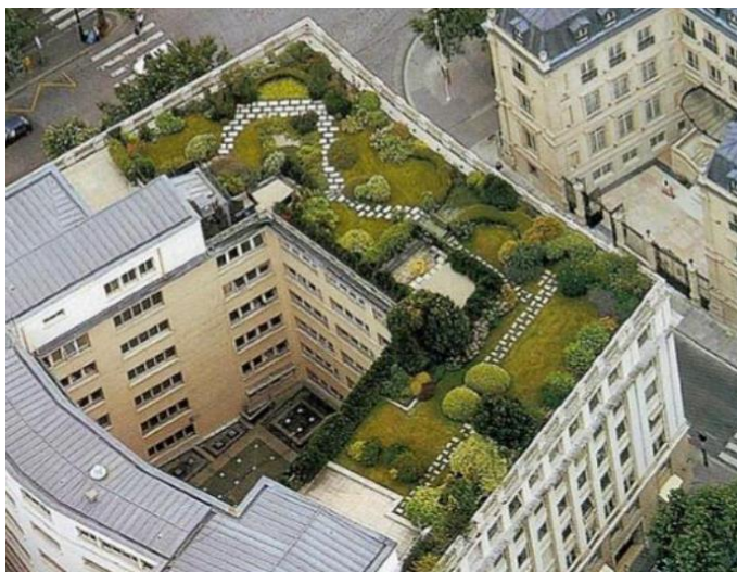
Figura 2 - Telhado verde intensivo
