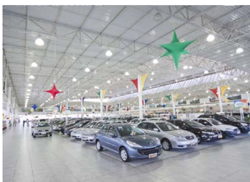
Figura 26: Estruturas metálicas do Vale Auto Shopping Blumenau.
