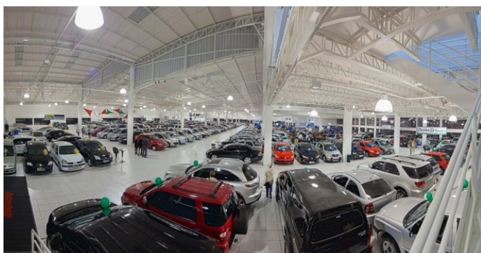
Figura 33: Estruturas do Auto Shopping Curitiba.
