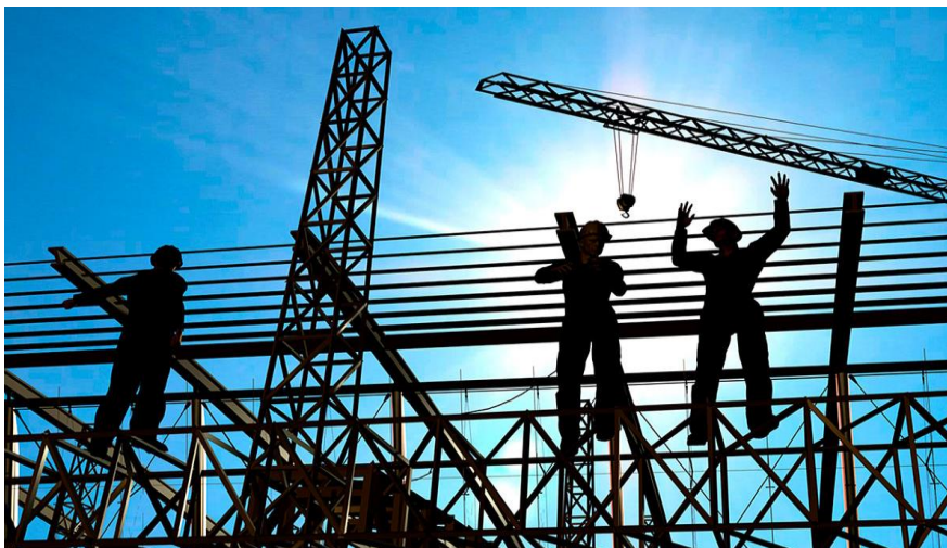
Figura 17 - Montagem de Estrutura Metálica
