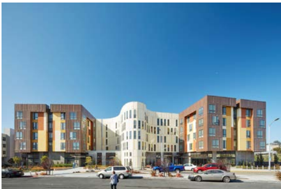
Figura 8: Fachada do Edifício
