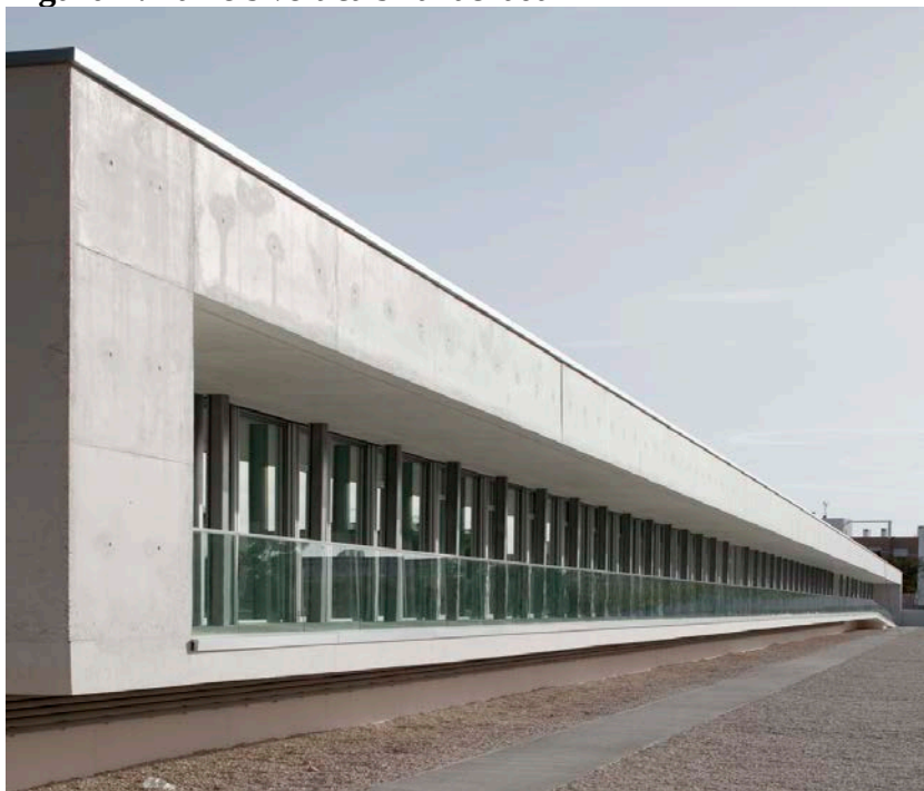
Figura 7: Painéis verticais na fachada
