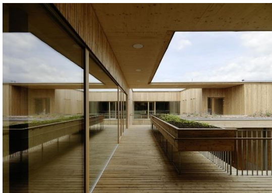
FIGURA 14: Interior da edificação
