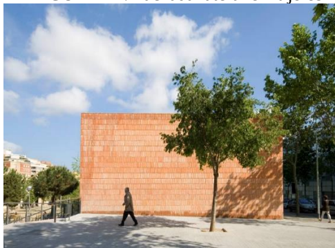
FIGURA 24: Fachada lateral em tijolos
