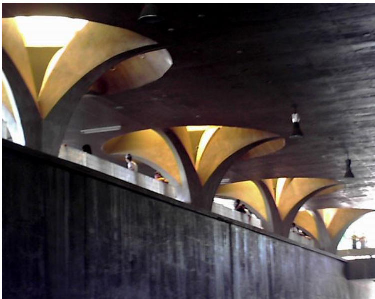
Figura 2: Detalhe do pilar da Estação Rodoviária de Jaú
