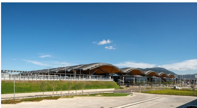
Figura 4: Terminal de Passageiros PCB
