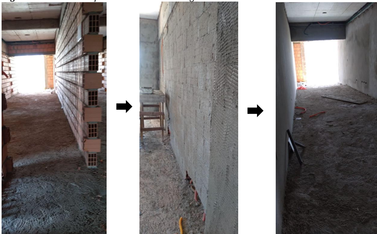
Figura 3: Fases do serviço de revestimento com argamassa.
