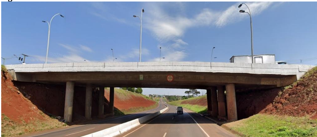
Figura 21 Viaduto 1 vista lateral
