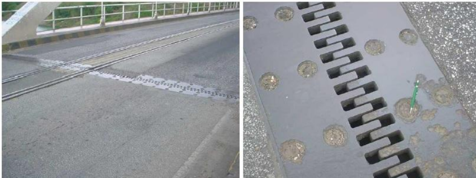
Figura 4 Juntas de dilatação em tabuleiros
