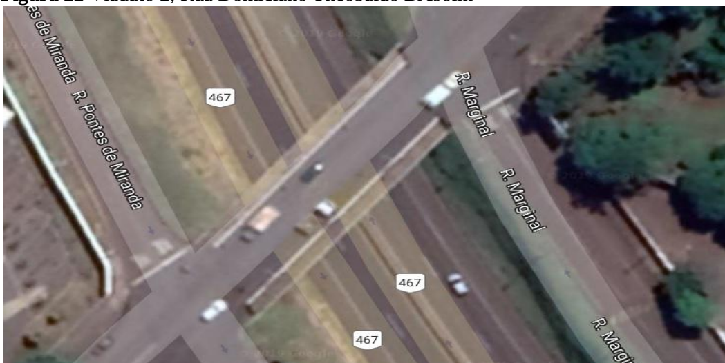
Figura 22 Viaduto 2, Rua Domiciano Theobaldo Bresolin
