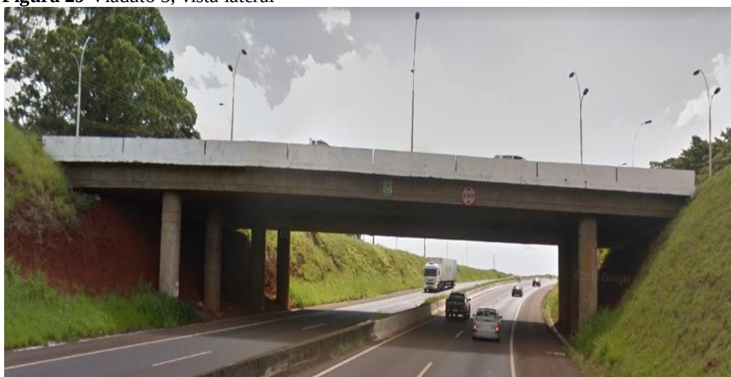
Figura 29 Viaduto 5, vista lateral
