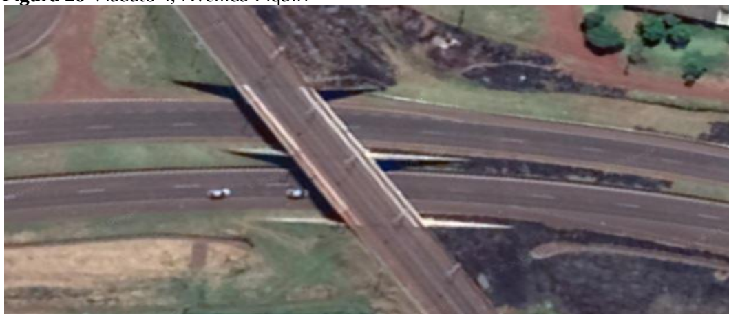
Figura 26 Viaduto 4, Avenida Piquiri
