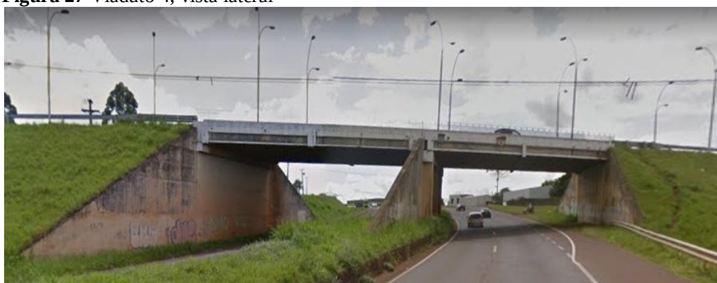
Figura 27 Viaduto 4, vista lateral
