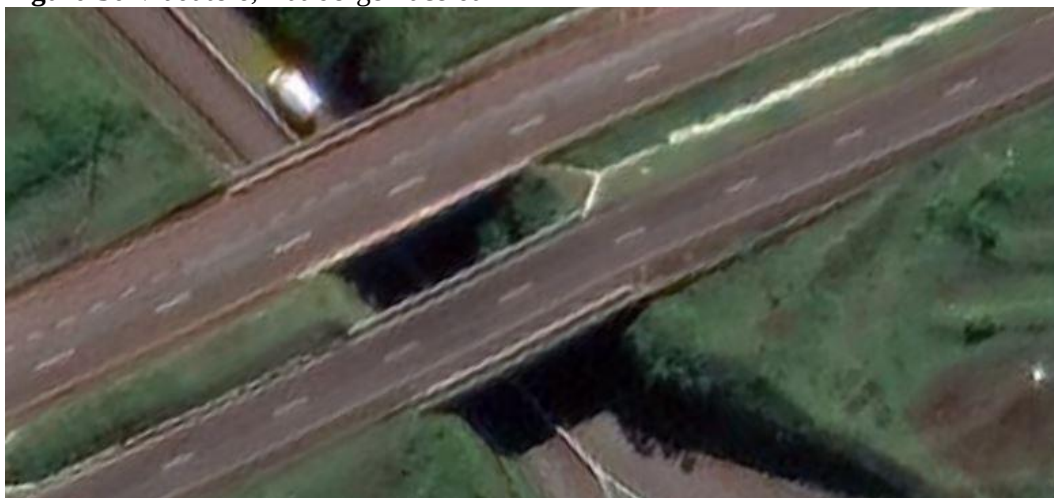
Figura 30 Viaduto 6, Rua Jorge Lacerda
