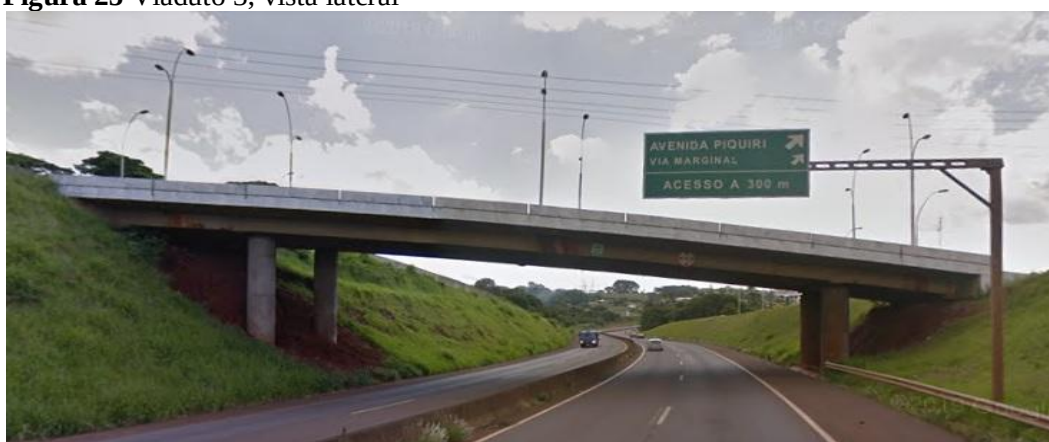
Figura 25 Viaduto 3, vista lateral
