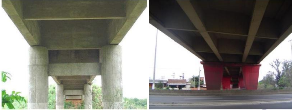
Figura 3 Vigas sobre tabuleiro
