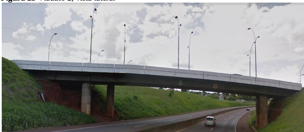
Figura 23 Viaduto 2, vista lateral
