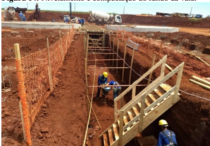
Figura 04: Nivelamento e compactação do fundo da vala.
