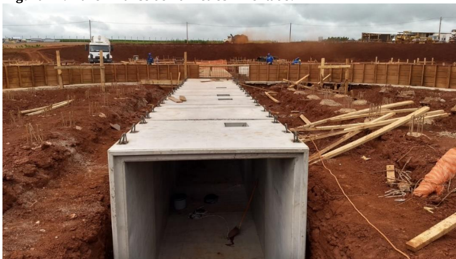
Figura 12: Túnel – lance de 20 metros - montado.
