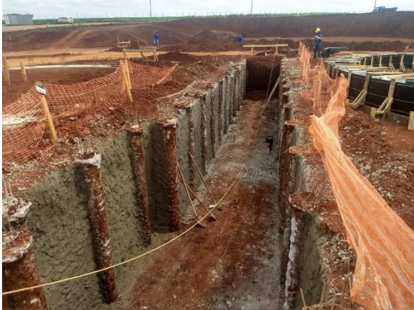
Figura 05: Chapisco nas paredes da valeta do túnel.
