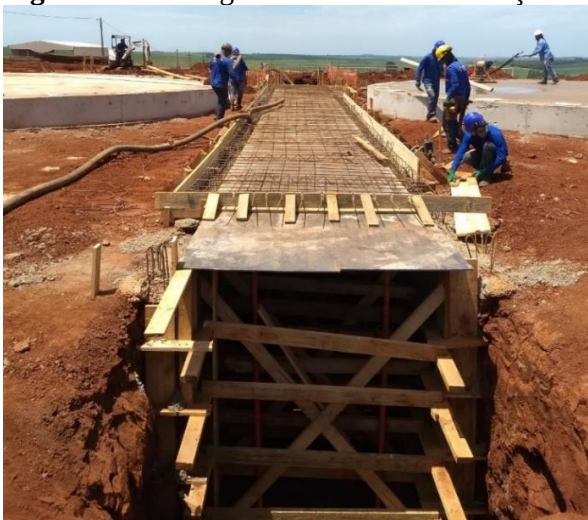
Figura 08: Montagens das fôrmas e colocações das armaduras.
