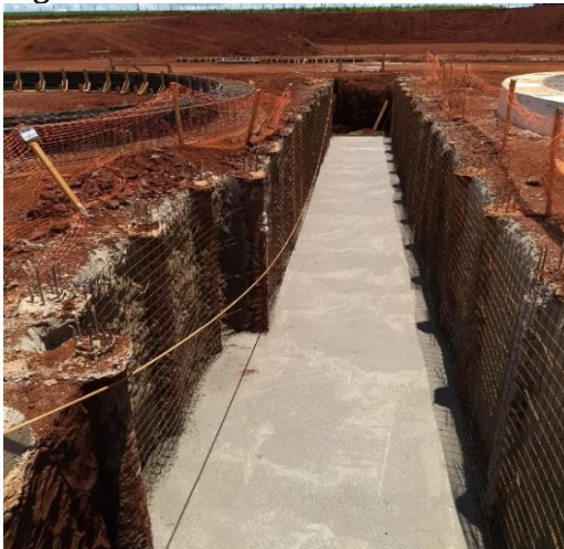
Figura 06: Piso do túnel acabado.
