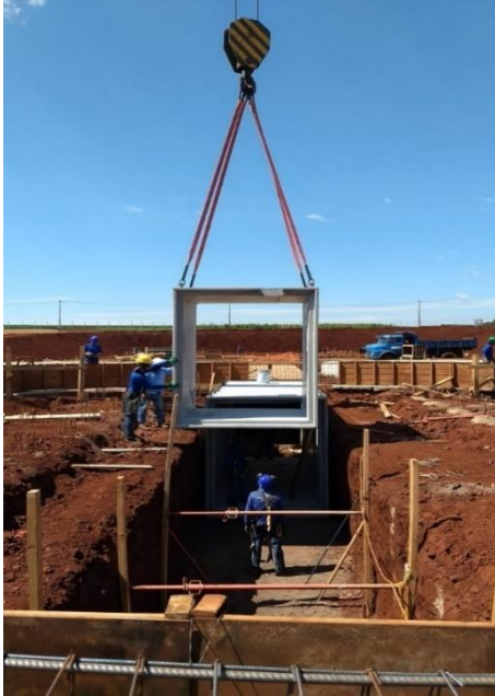
Figura 10: Montagem do túnel pré-fabricado.
