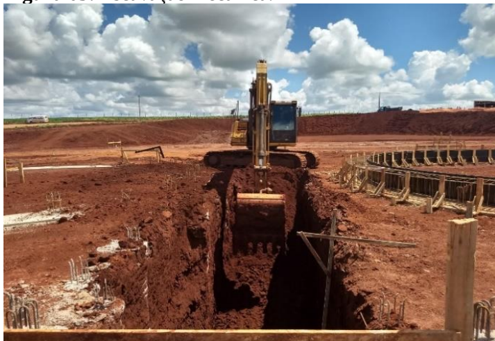
Figura 03: Escavação mecânica.
