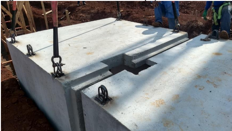
Figura 11: Encaixe macho e fêmea das peças do túnel.
