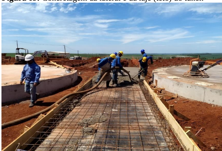
Figura 09: Concretagem da lateral e da laje (teto) do túnel.
