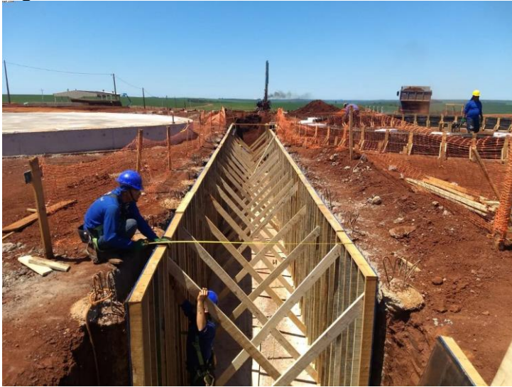
Figura 07: Fôrmas laterais do túnel.
