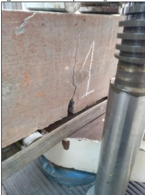
Figura 5 – Detalhe da ruptura da viga V1.
