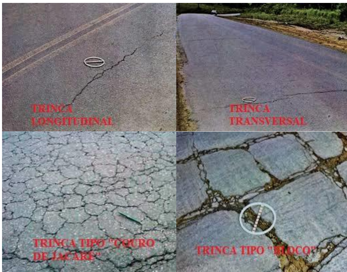
Figura 5: Tipos de trincas.
