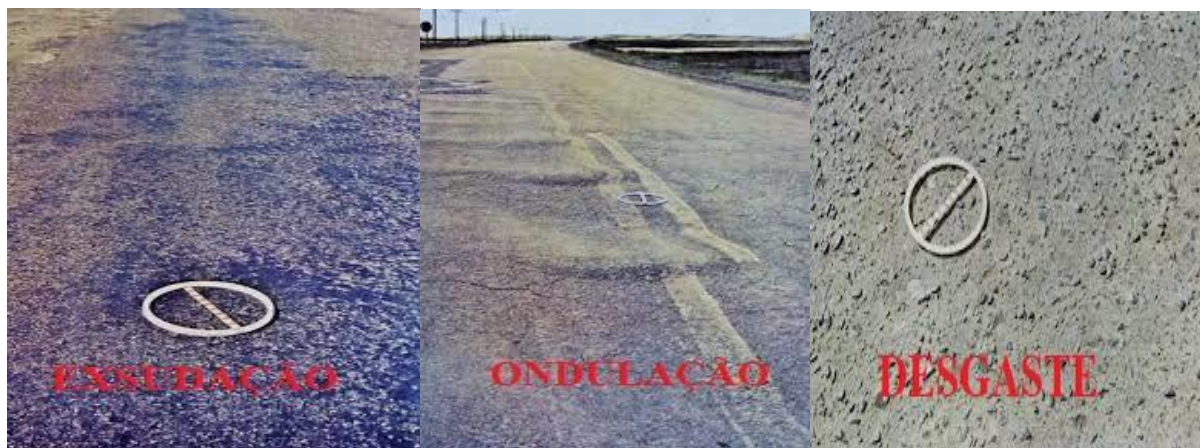
Figura 4: Exsudação, Desgaste e Ondulação.
