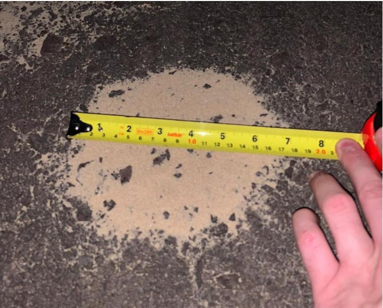
Figura 8 – Medição da mancha de areia.
