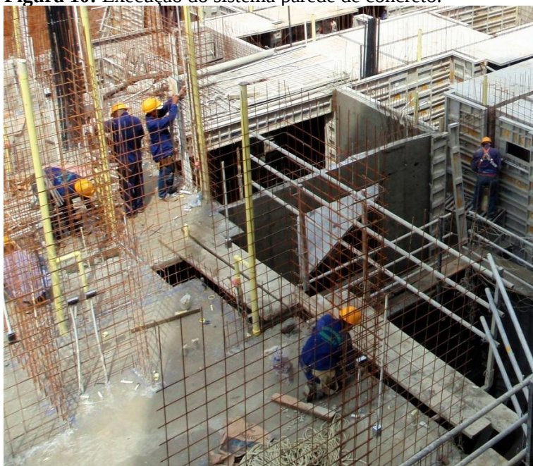
Figura 10: Execução do sistema parede de concreto.
