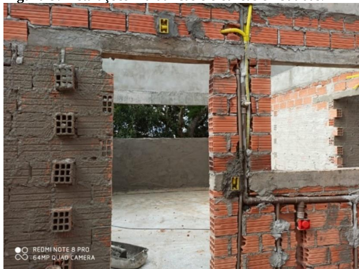
Figura 9: Instalações hidráulicas e elétricas embutidas.
