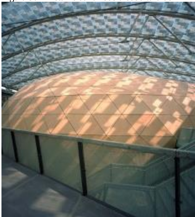
Figura 50 – Detalhe da luz sob a cobertura de ETFE
