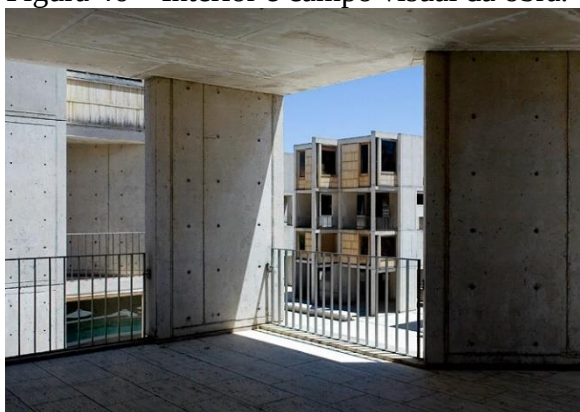
Figura 46 – Interior e campo visual da obra.
