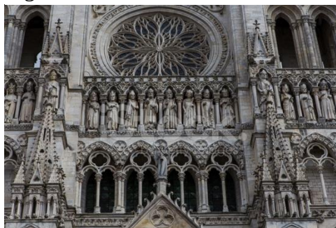
Figura 1 – Detalhes da fachada da
