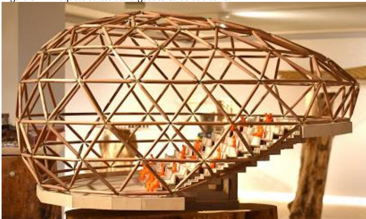
Figura 51 – Maquete da estrutura geodésica do auditório.
