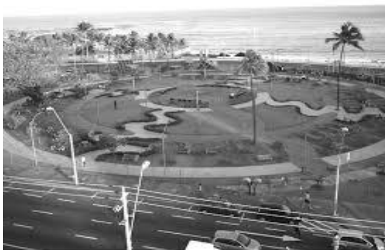
Figura 01– Vista da Praça após a intervenção
