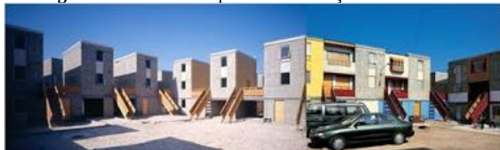
Figura 13 - Antes de depois da intervenção dos moradores
