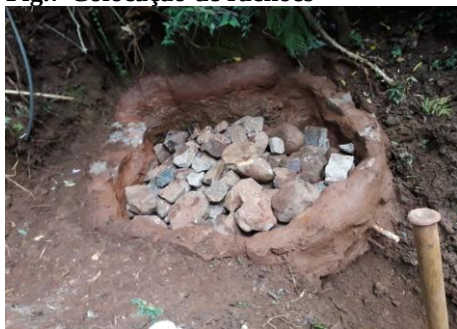
Fig.7 Colocação de rachões
