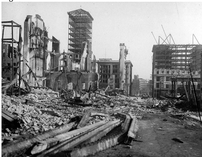
Figura 6: Pós-abalo sísmico San Francisco 1906.
