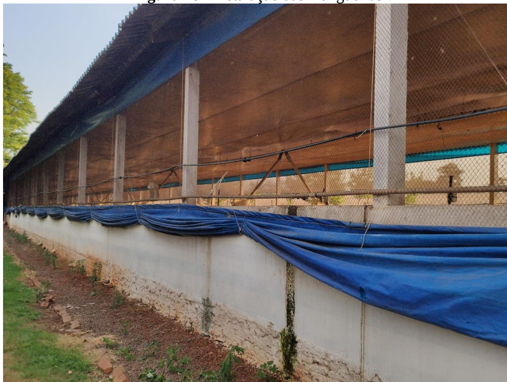
Figura 18 - Instalação das mangueiras
