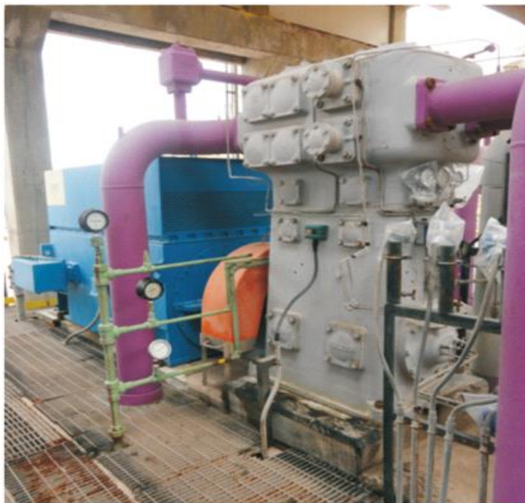
Figura 5: Compressor alternativo Sulzer
