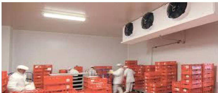
Figura 10: Evaporador circulação forçada
