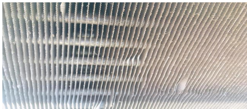
Figura 12 - Resfriador de tubos aletados
