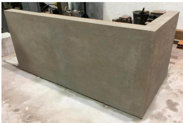
Figura 3: Execução do emboço na alvenaria.
