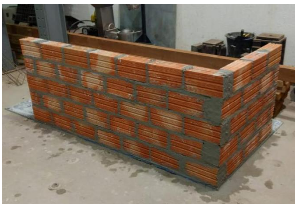
Figura 1: Execução da alvenaria.
