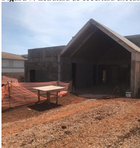
Figura 7: Estrutura de cobertura executada.
