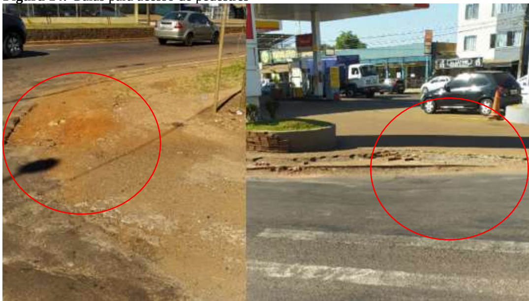
Figura 14: Guias para acesso de pedestres
