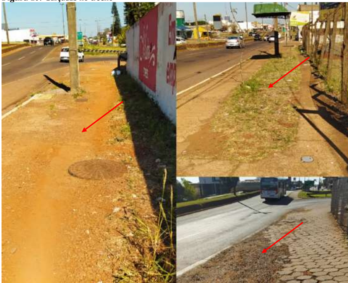
Figura 10: Calçadas no trecho
