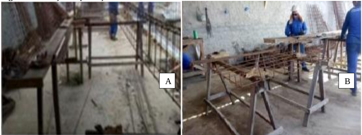
Figura 5 – Estação de produção de armaduras.
