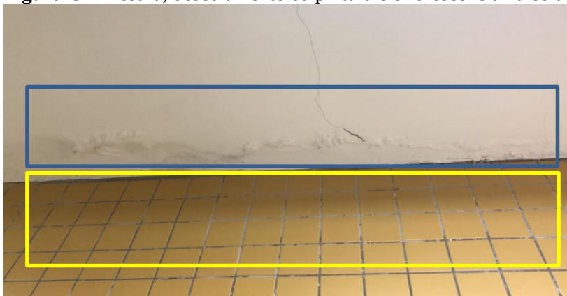
Figura C – Fissura, descolamento da pintura e eflorescência na cerâmica
