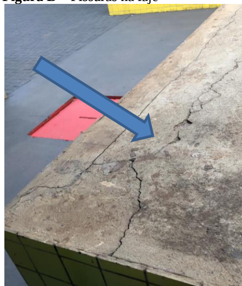
Figura C – Fissura, descolamento da pintura e eflorescência na cerâmica
