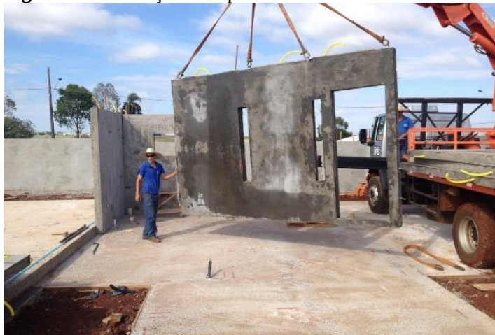
Figura 2: Construção com painéis de concreto com bloco cerâmico
