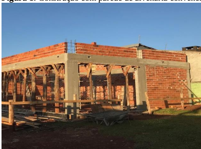
Figura 1: Construção com parede de alvenaria convencional
