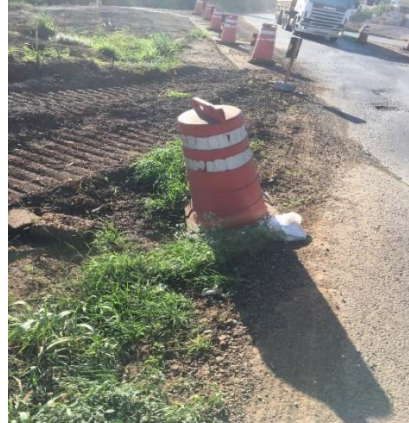
Figura 30: Cilindro em más condições
