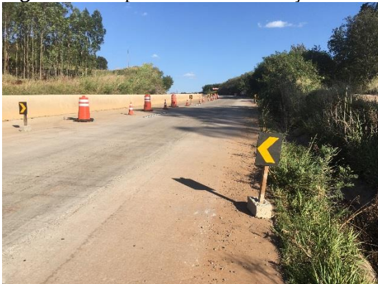
Figura 21: Dispositivos de canalização Obra 1
