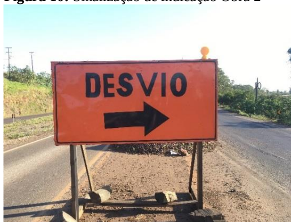
Figura 10: Sinalização de indicação Obra 2
