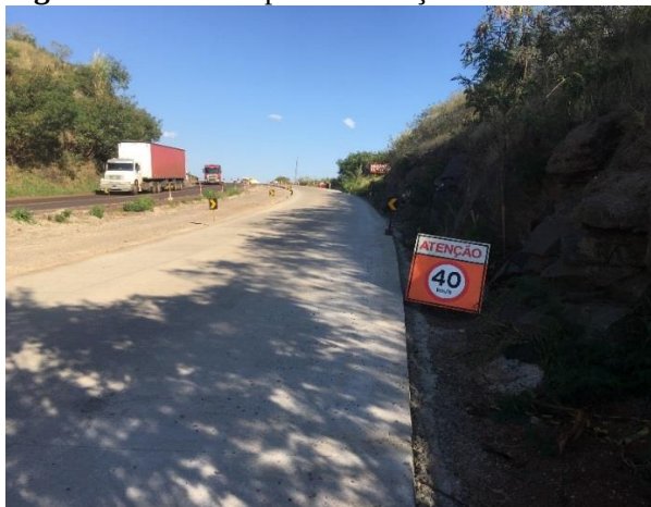
Figura 13: Área de pré-sinalização Obra 1
