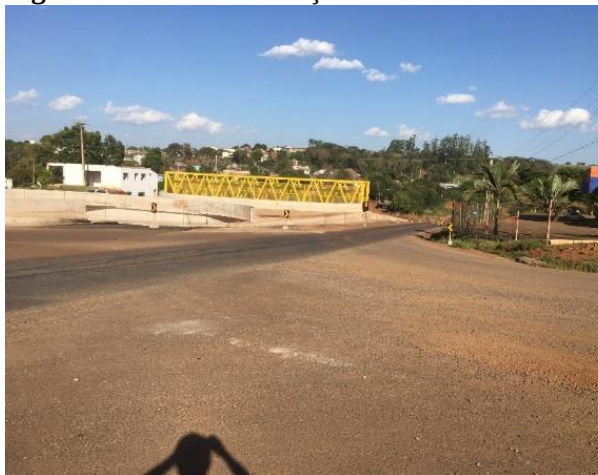
Figura 11: Área de transição Obra 1
