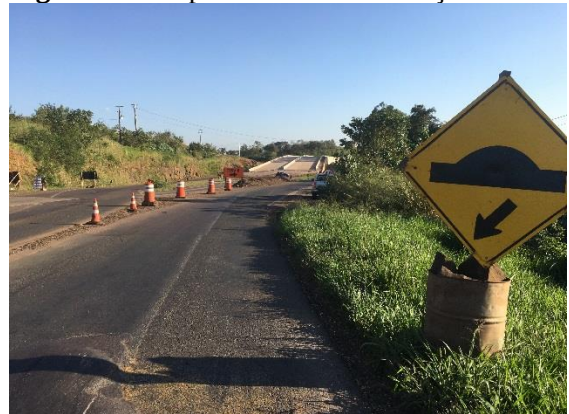
Figura 22: Dispositivos de canalização Obra 2
