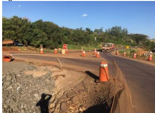
Figura 12: Área de retorno Obra 1
