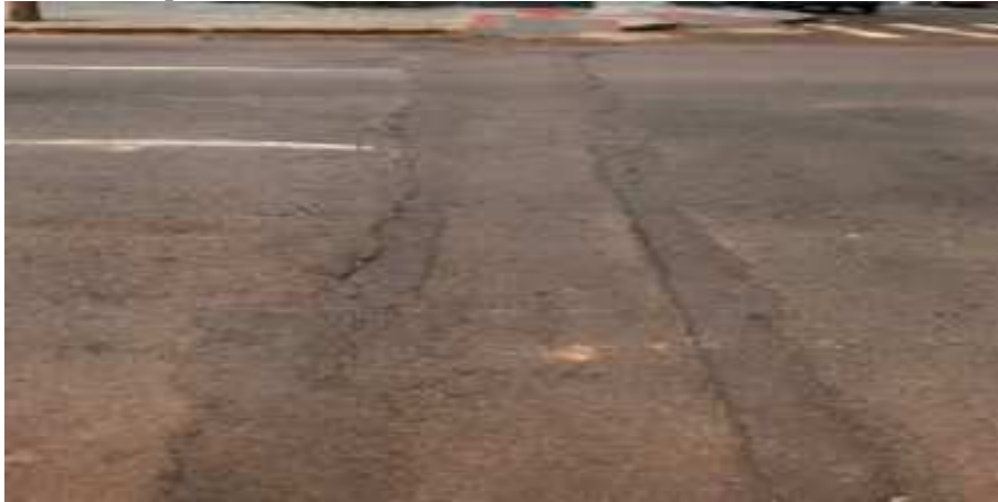
Figura 6: Reparo de travessia transversal
