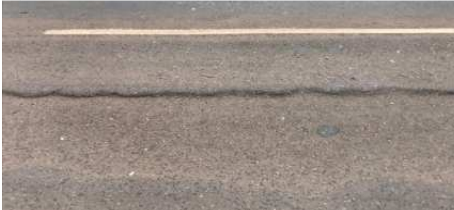
Figura 18: Afundamento Plástico
