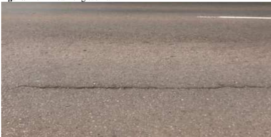
Figura 11: Trinca Longitudinal
