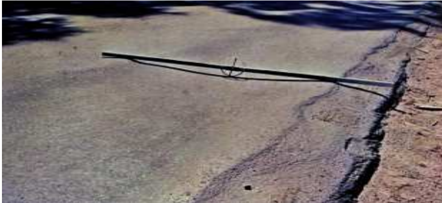
Figura 18: Afundamento Plástico
