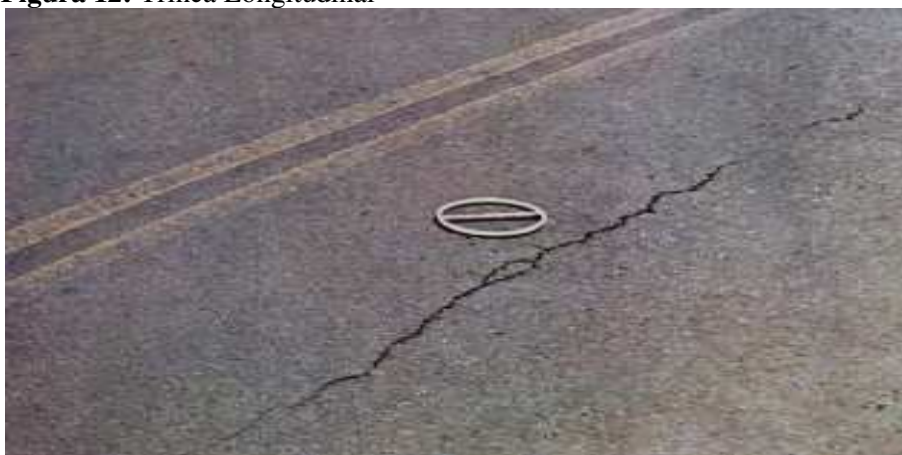
Figura 12: Trinca Longitudinal
