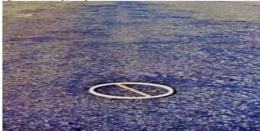
Figura 5: Exsudação do pavimento
