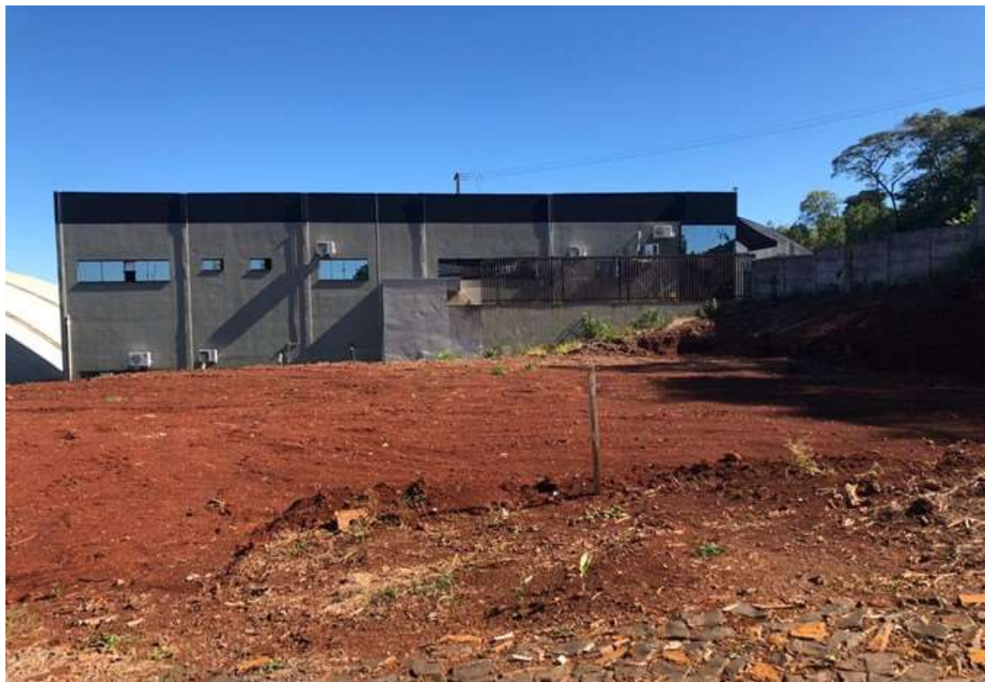
Figura 2: Vista frontal do terreno da realização da cervejaria.
