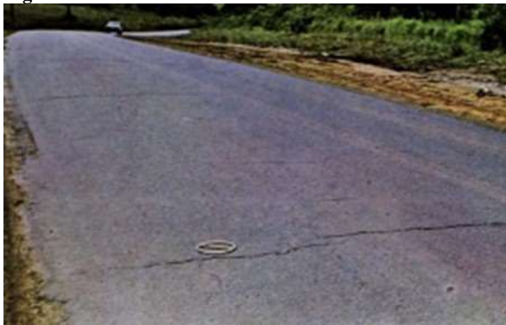
Figura 04: Trincas transversais
