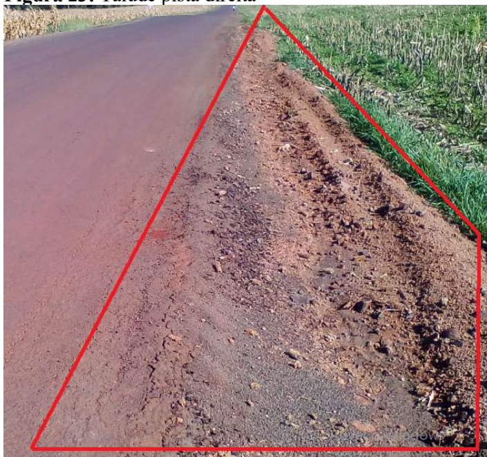
Figura 23: Talude pista direita
