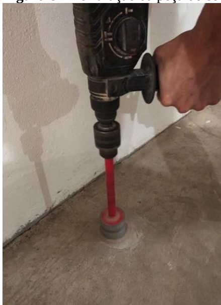
Figura 8 – Perfuração da peça de concreto
