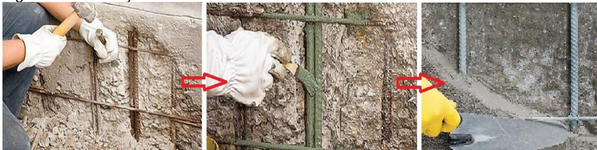
Figura 11 – Intervenção estrutural convencional
