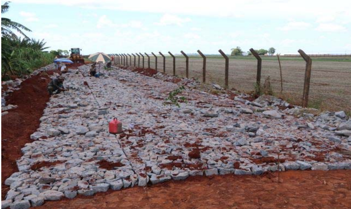
Figura 4 - Pavimento poliédrico em construção.
