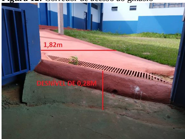
Figura 12: Corredor de acesso ao ginásio
