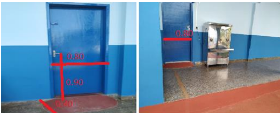
Figura 13: Porta de acesso aos ambientes
