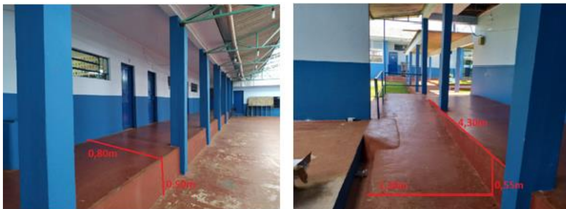
Figura 10 e 11: Corredor e rampa de acesso a salas de aulas
