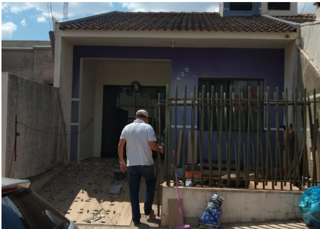
Imagem 1 – Fachada frontal antes da implantação do design biofílico.
