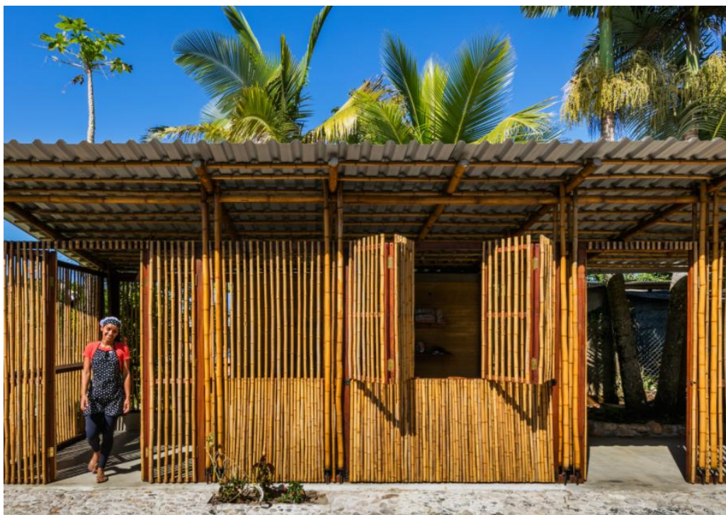
Figuras 2, 3, 4 e 5 – Centro Comunitário Camburi, CRU! Architects
