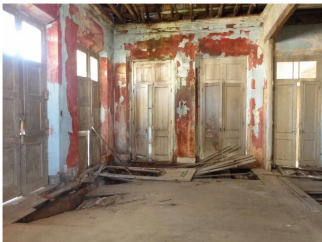
Imagem 11 – Casarão Hercílio Luz – Parte interna antes do restauro.
