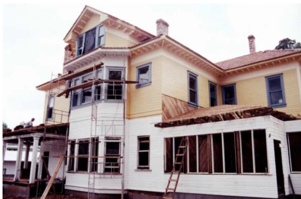
Imagem 4 – Casa Gomm – Durante restauro.
