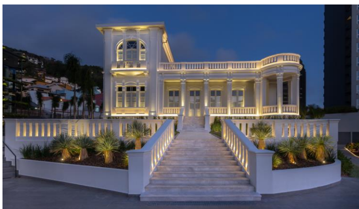
Imagem 10 – Casarão de Hercílio Luz – Após restauro.
