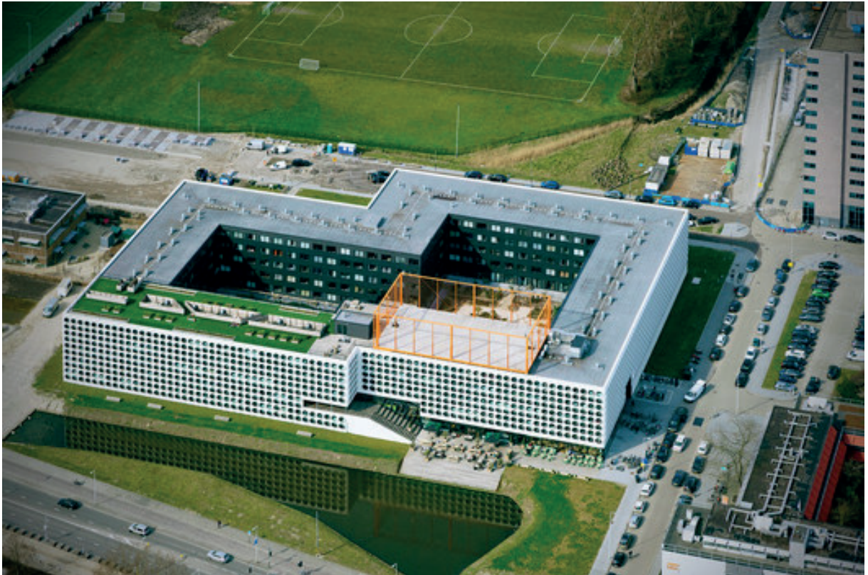
Vista Superior do edifício
