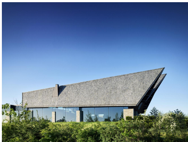
Figura 05: Cobertura - Clube e Hotel Great Northern
