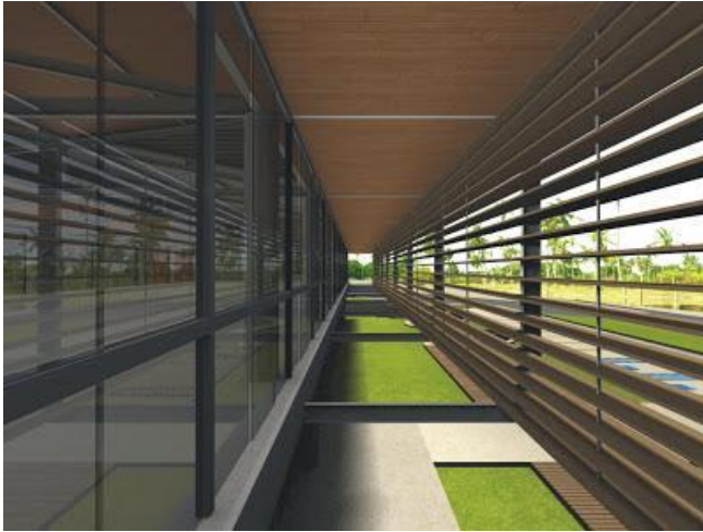
Figura 03: Brises fixados nas estruturas metálicas.
