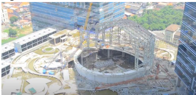
Figura 09: Estrutura do Anfiteatro
