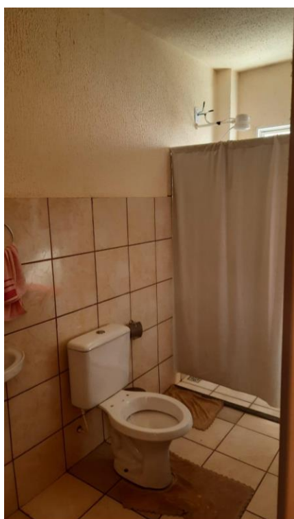
Figura 4 – Banheiro habitação tipo 01
