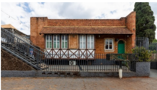
Figura 6 – Fachada Rua Independência
