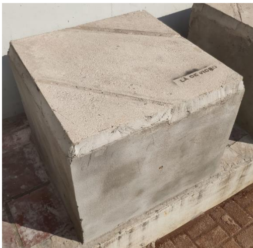
Figura 2: Protótipo em alvenaria.
