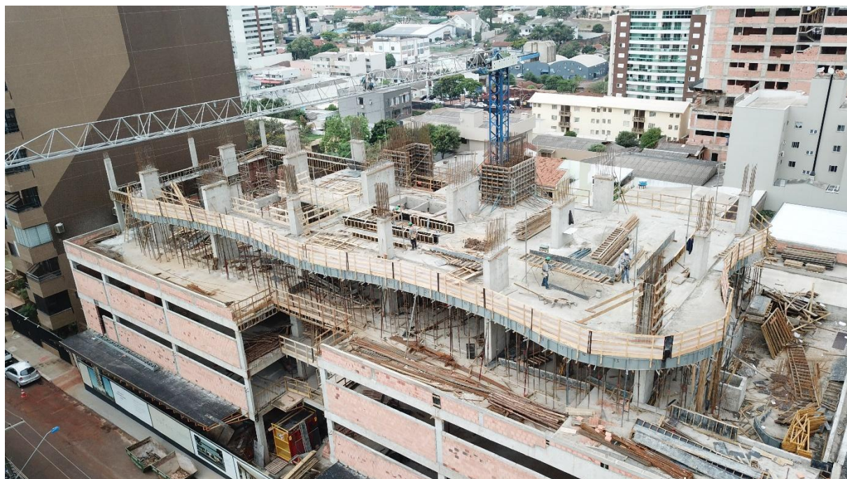
FIGURA 36: Imagem aérea da fôrma instalada.
