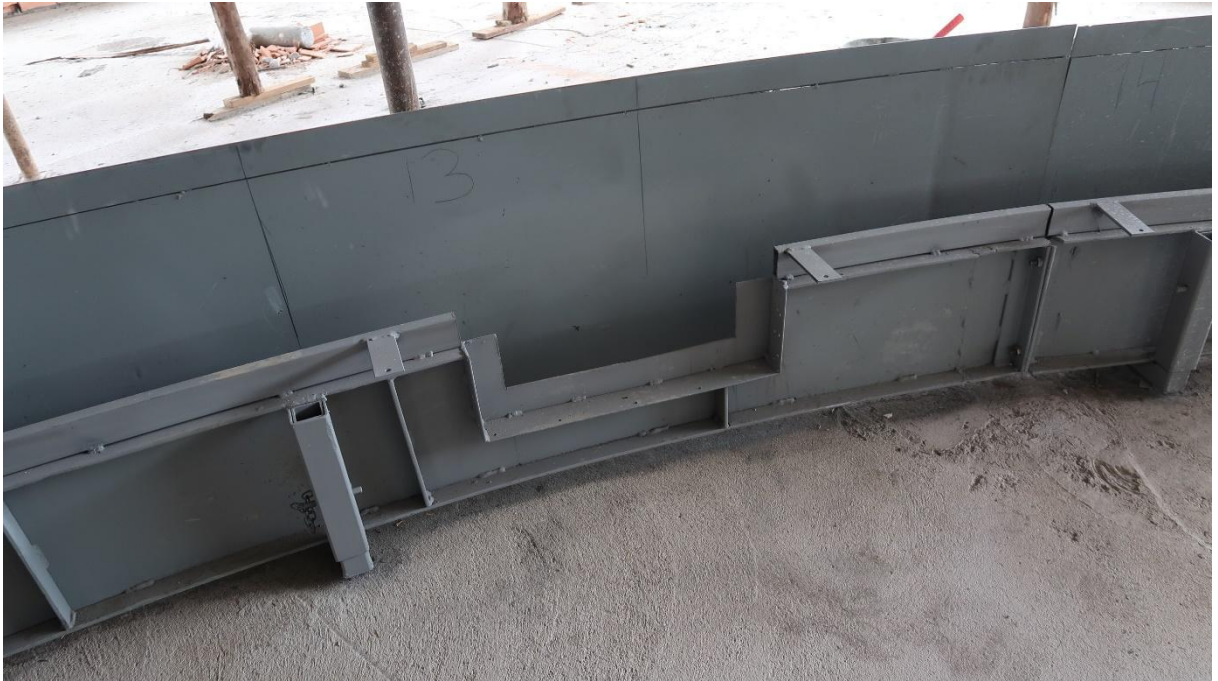
FIGURA 28: Corte da chapa interna para as caixarias.
