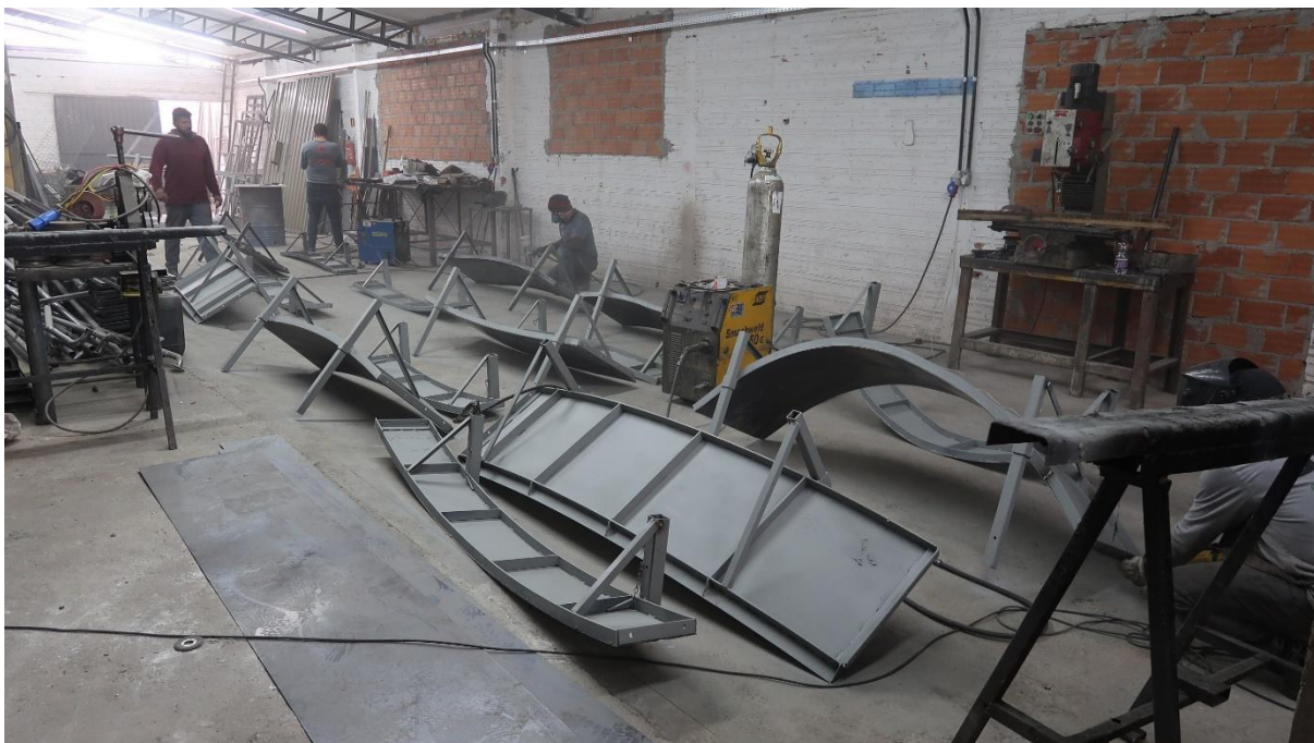
FIGURA 19: Partes da fôrma na estufa de pintura com fundo anticorrosivo.
