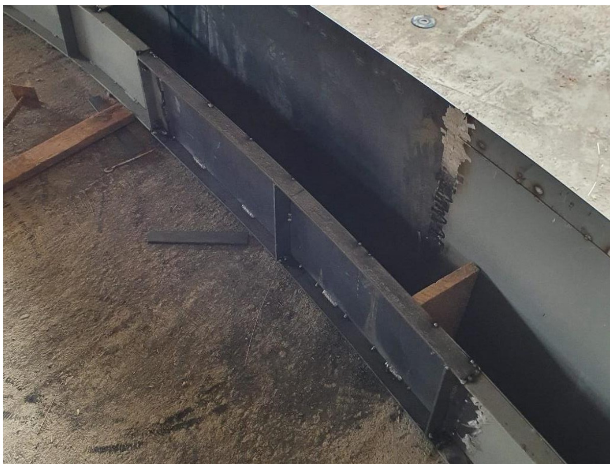
FIGURA 26: Soldagem da chapa metálica adaptada interna.
