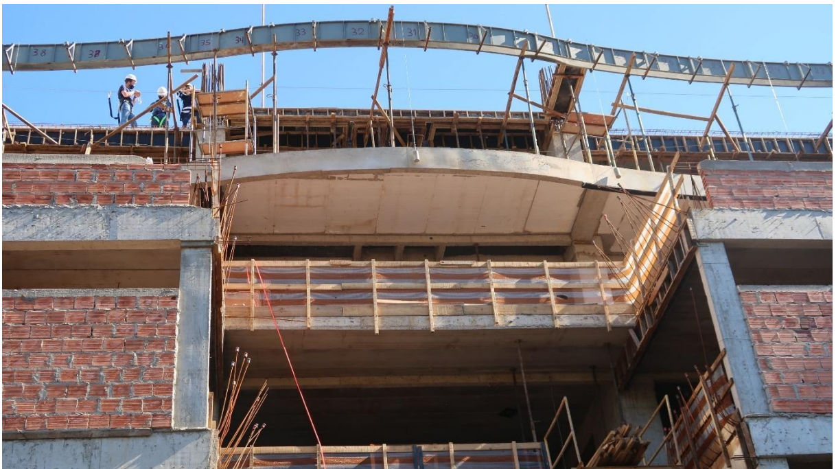
FIGURA 46: Parte central da fôrma fixada no segundo pavimento.
