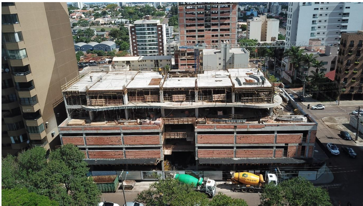
FIGURA 39: Vista aérea da obra sem a fôrma no lado direito da obra.
