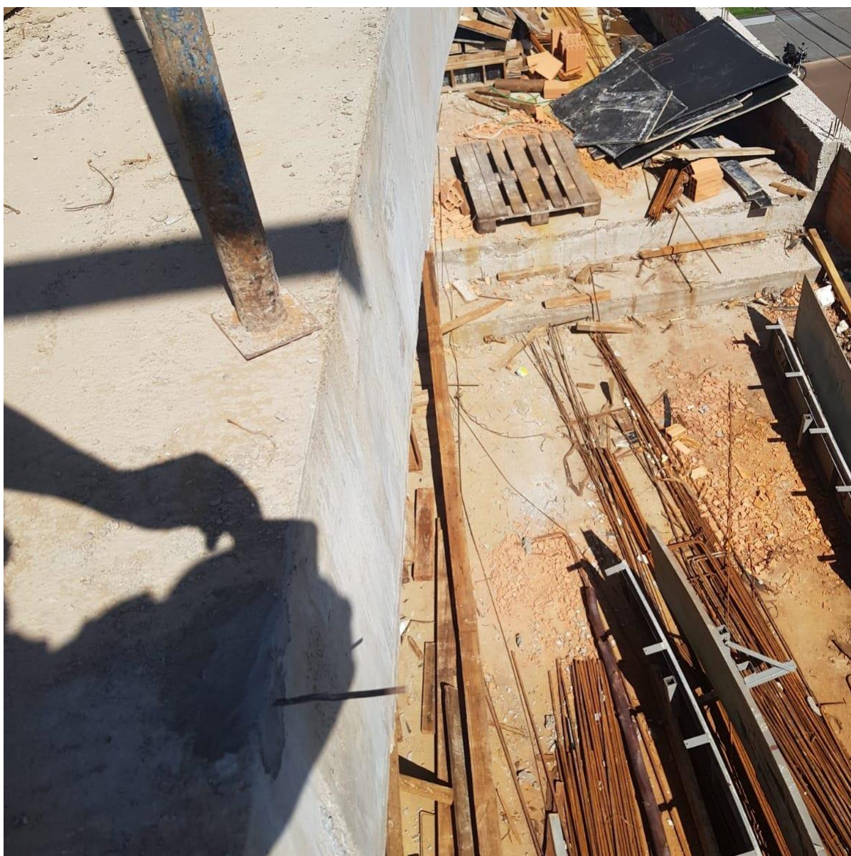
FIGURA 41: Acabamento superficial da viga de concreto armado.
