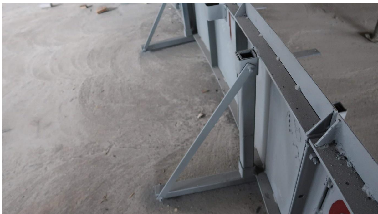
FIGURA 31: Novo sistema de fixação por tubos.
