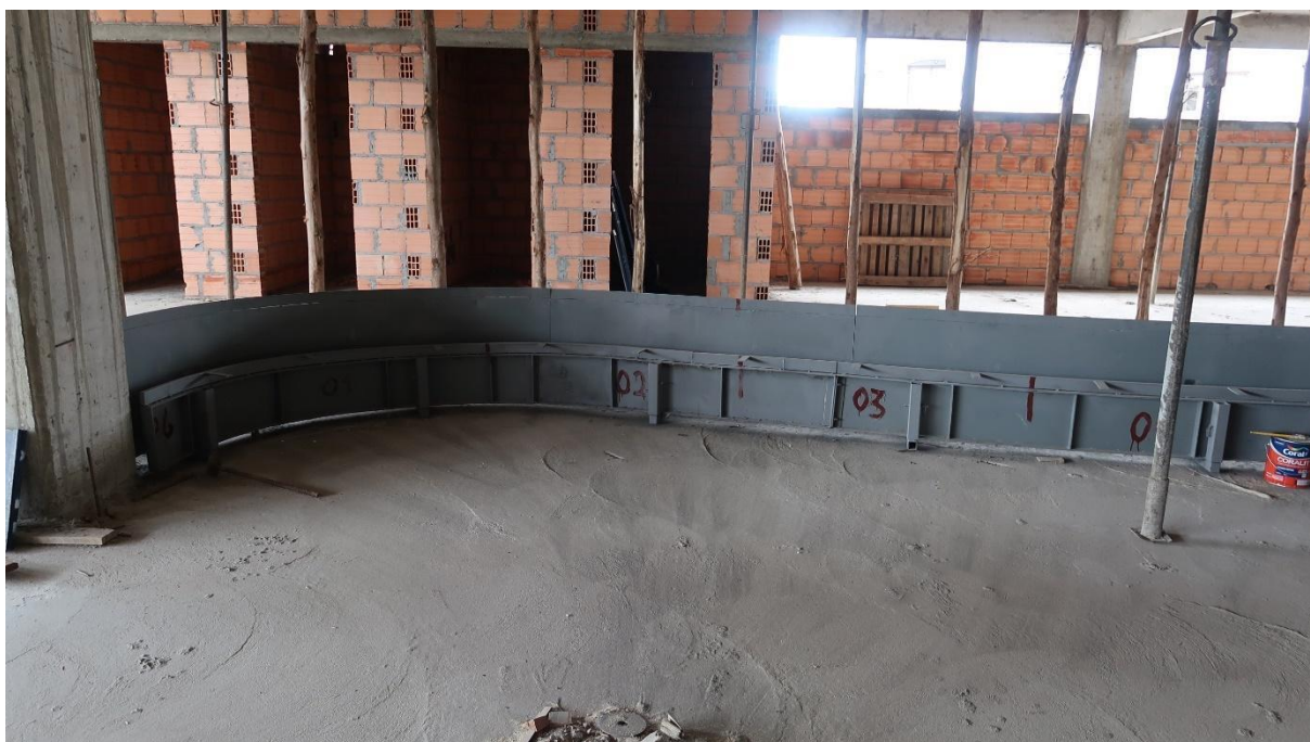
FIGURA 51: Marcação da sequência das partes das fôrmas.
