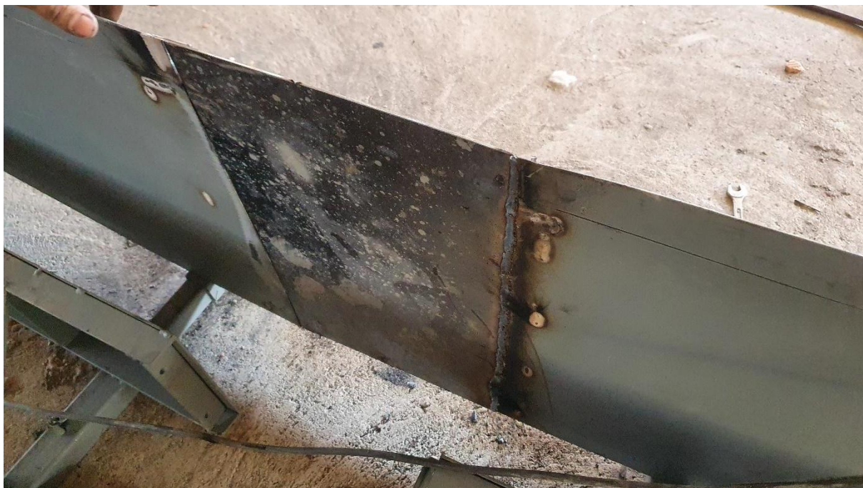
FIGURA 25: Soldagem da chapa metálica adaptada externa.
