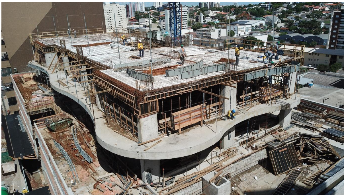
FIGURA 38: Retirada parcial da fôrma no primeiro pavimento.
