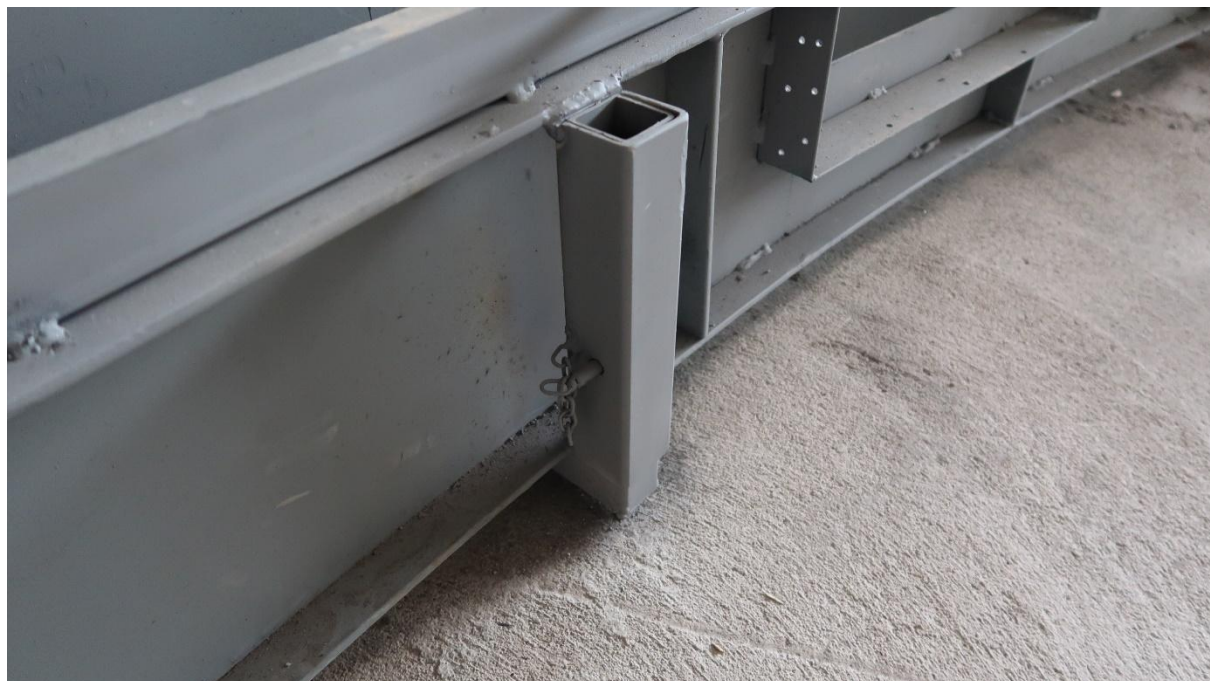
FIGURA 50: Fixação da fôrma interna.
