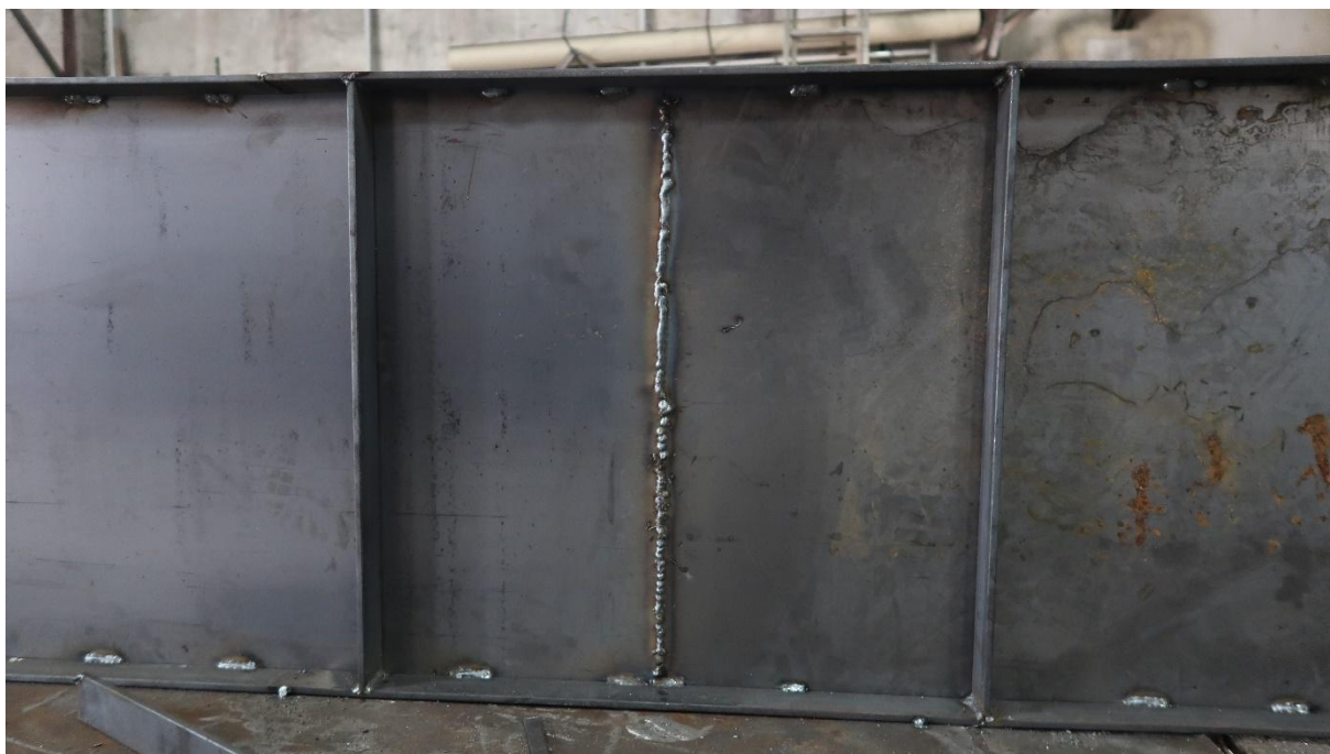
FIGURA 14: Soldagem das chapas e dos reforços.
