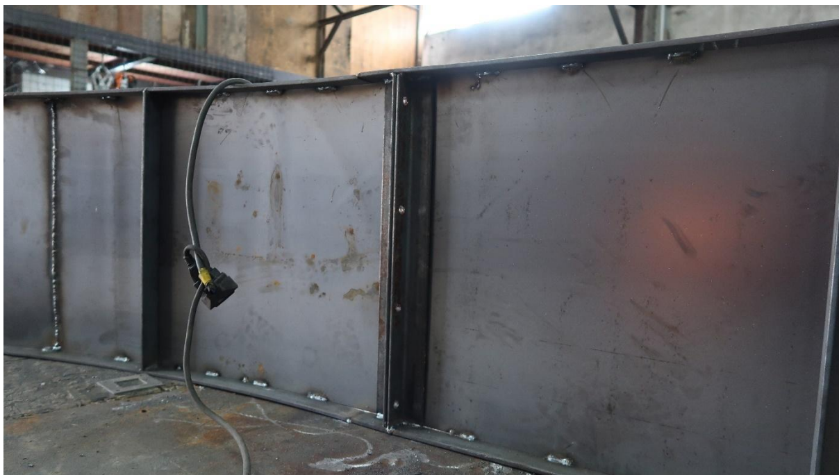
FIGURA 15: Soldagem das cantoneiras de fixação na fôrma. (Fonte: Autor, 2021).
