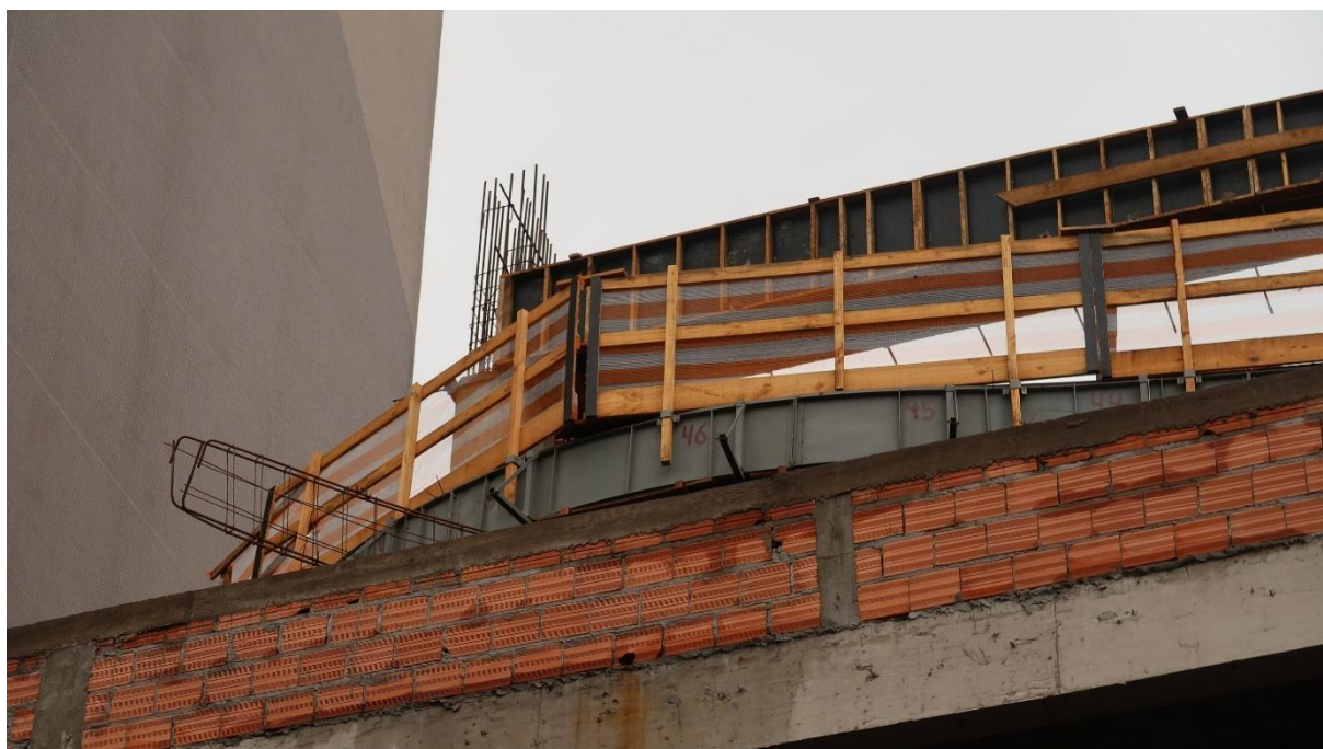
FIGURA 52: Guarda-corpo de madeira instalado.
