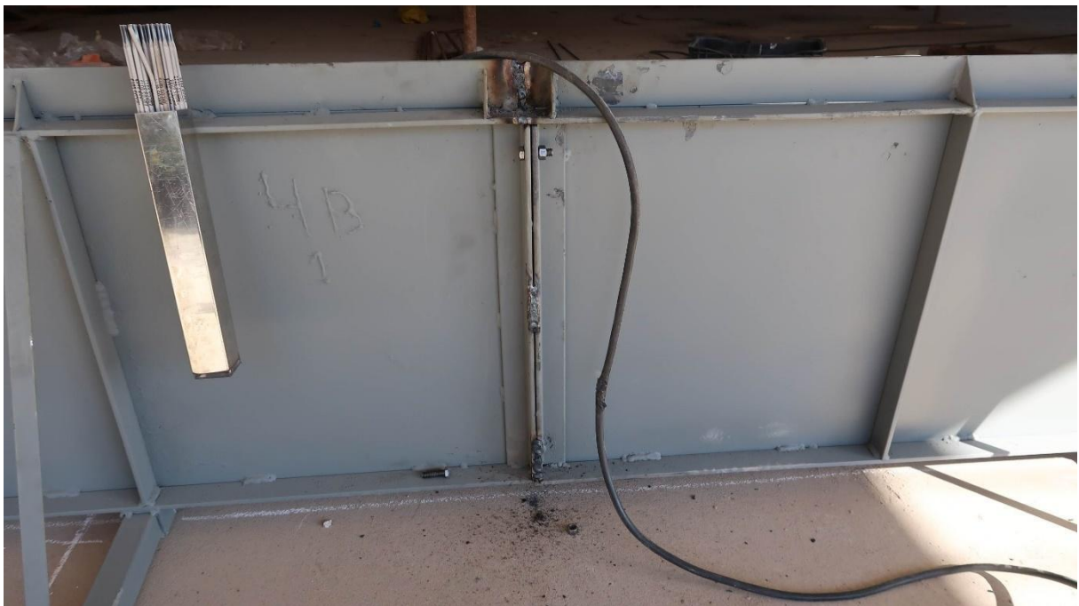
FIGURA 24: Soldagem das cantoneiras para içamento.
