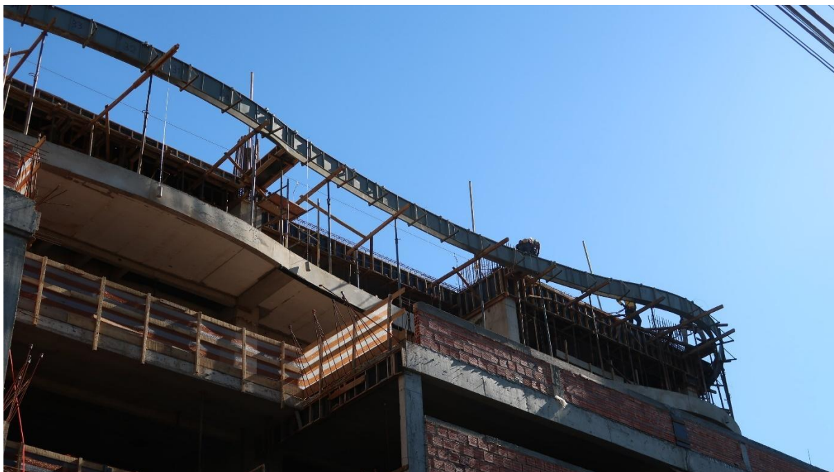
FIGURA 43: Parte direita da fôrma fixada no segundo pavimento.
