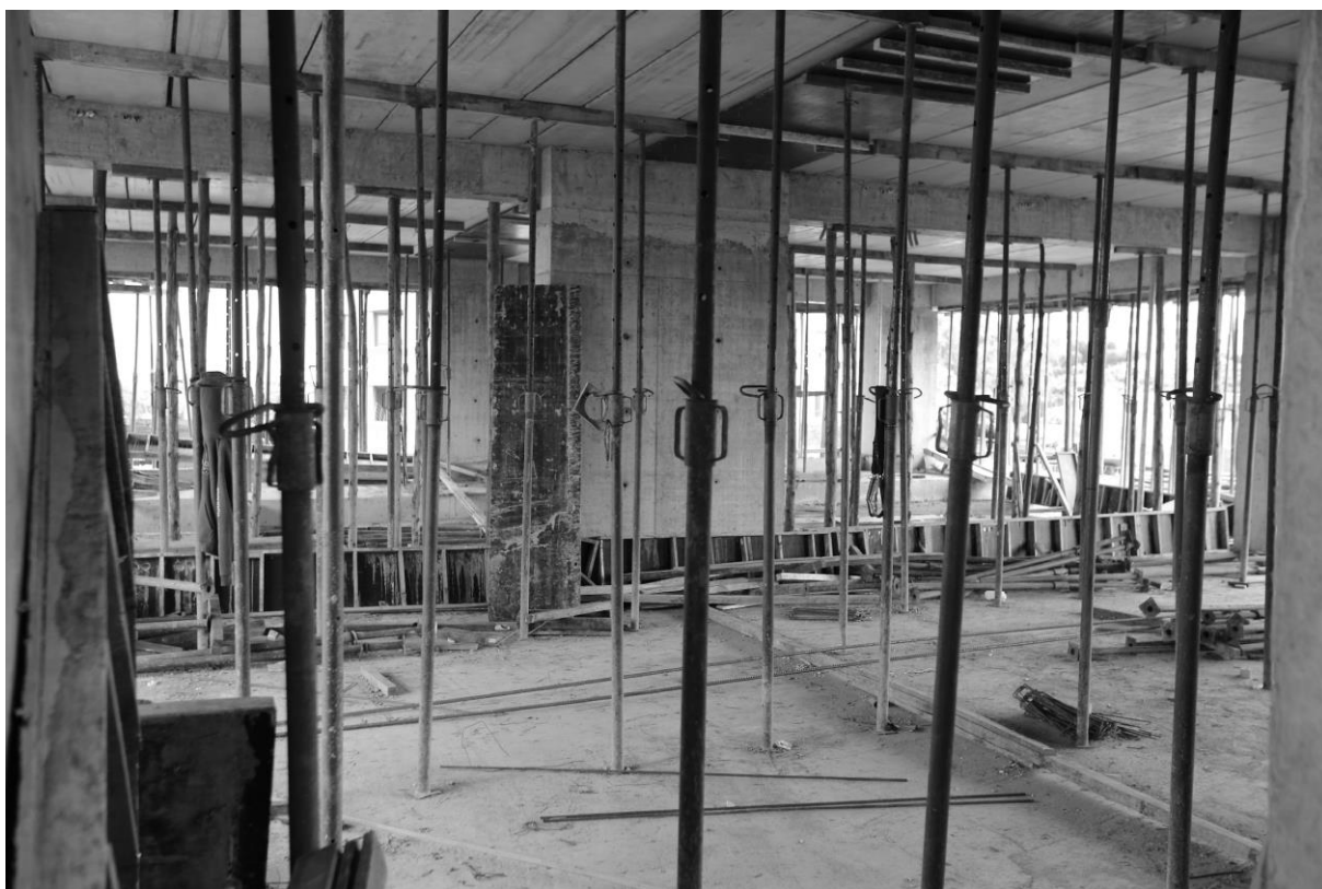
FIGURA 48: Escoras instaladas na parte interna da obra.
