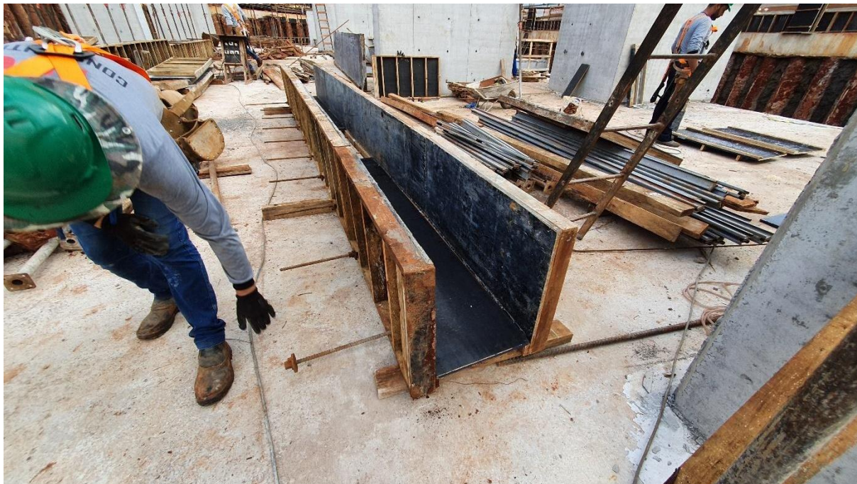
FIGURA 49: Caixaria de madeira para vigas de concreto armado.
