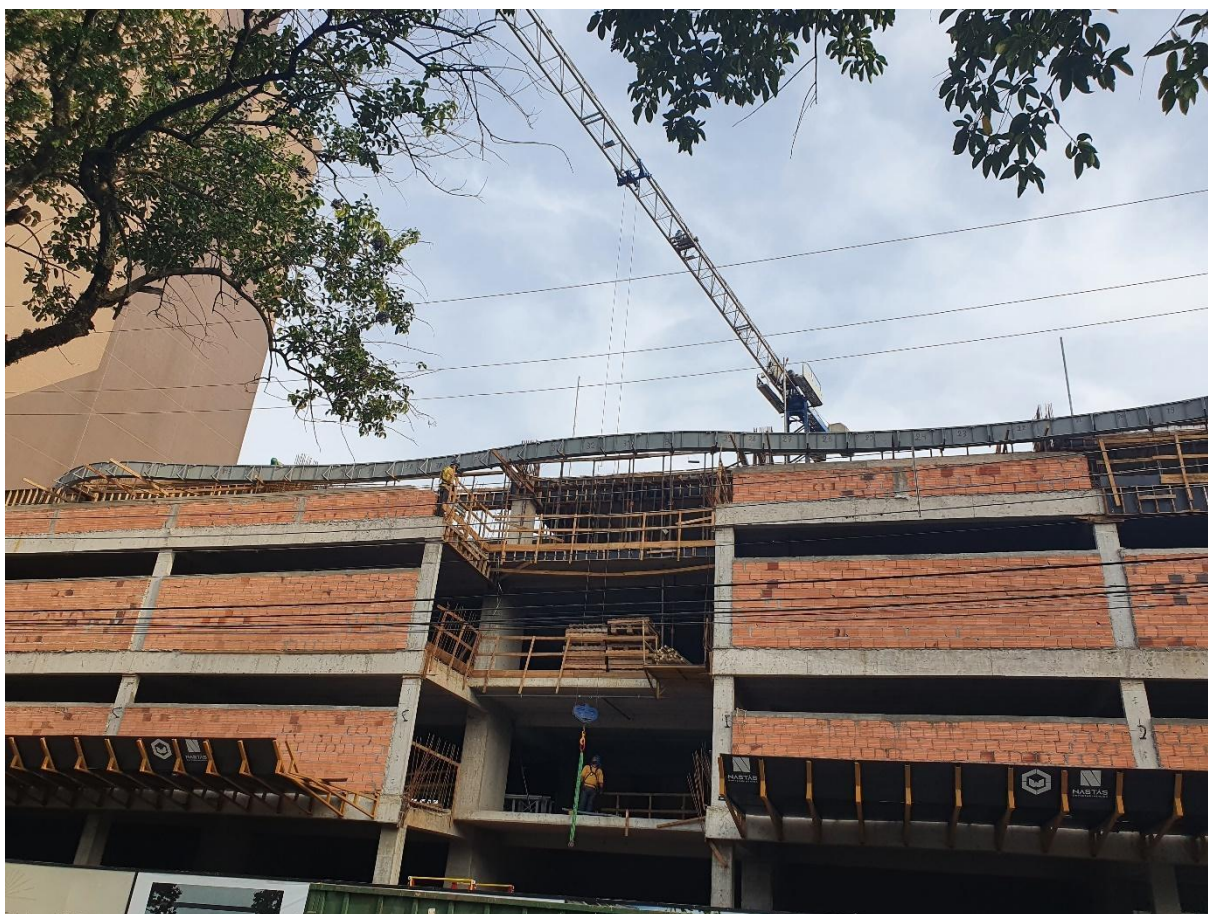
FIGURA 34: Fixação da fôrma no primeiro pavimento.
