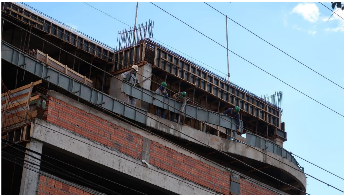
FIGURA 37: Funcionários iniciando a retirada da fôrma.
