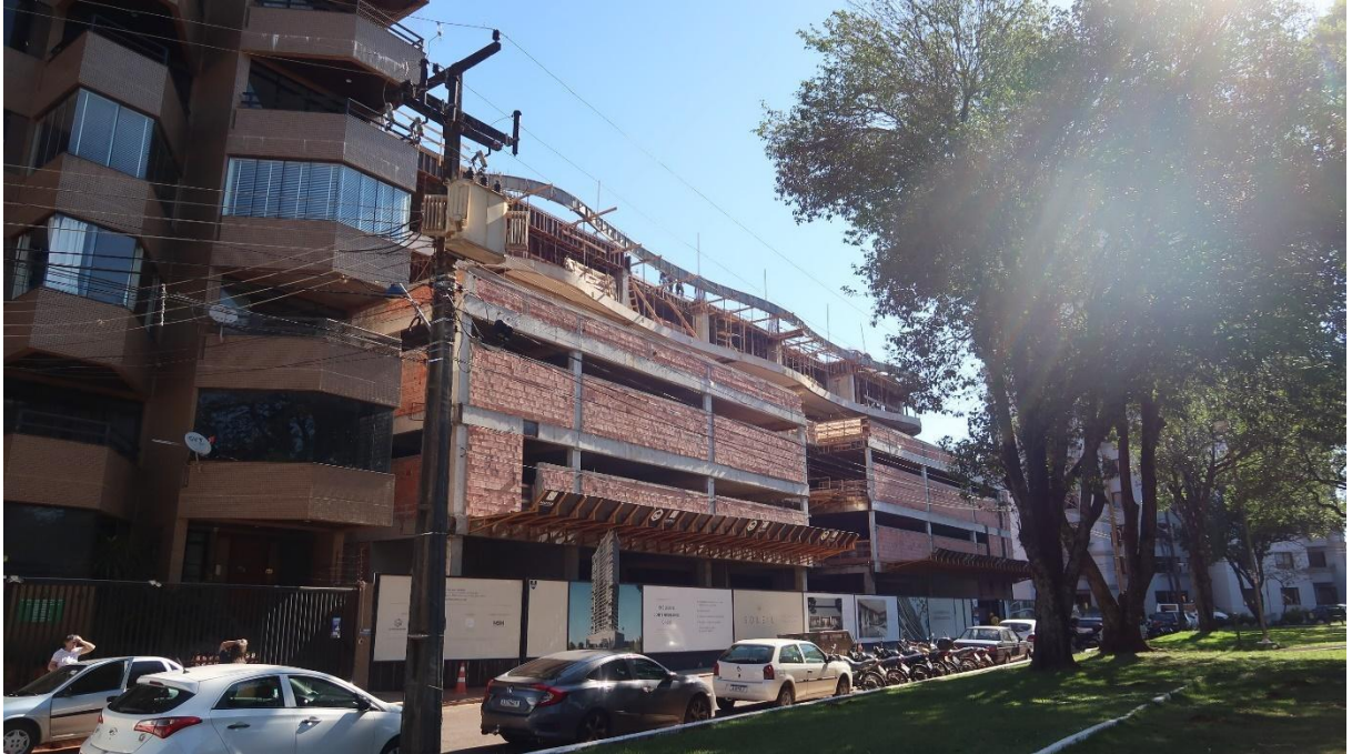
FIGURA 45: Fôrma instalada no segundo pavimento.
