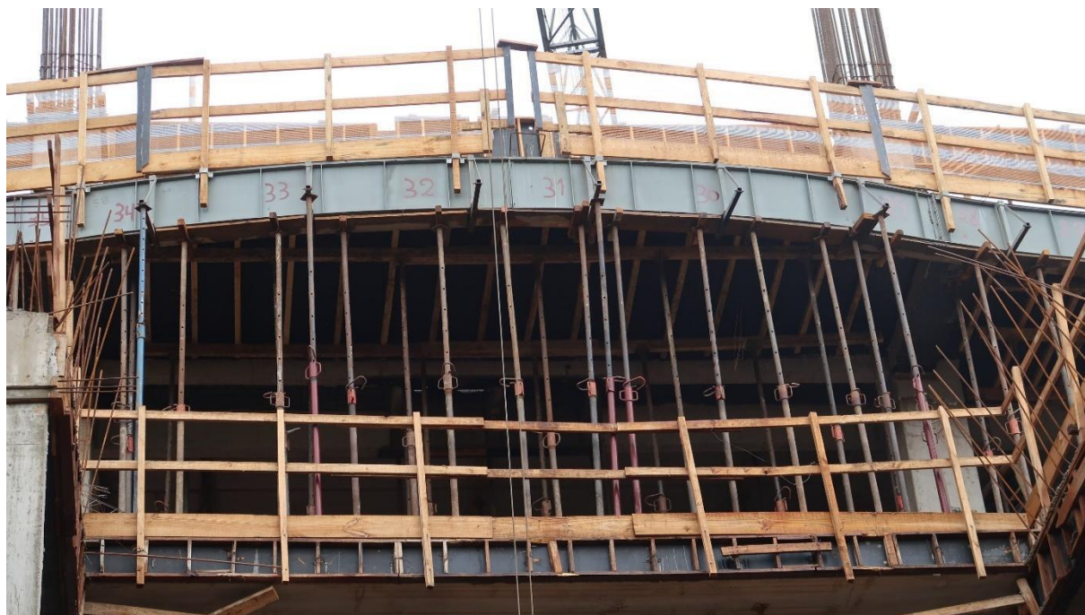
FIGURA 35: Escoramento da fôrma.
