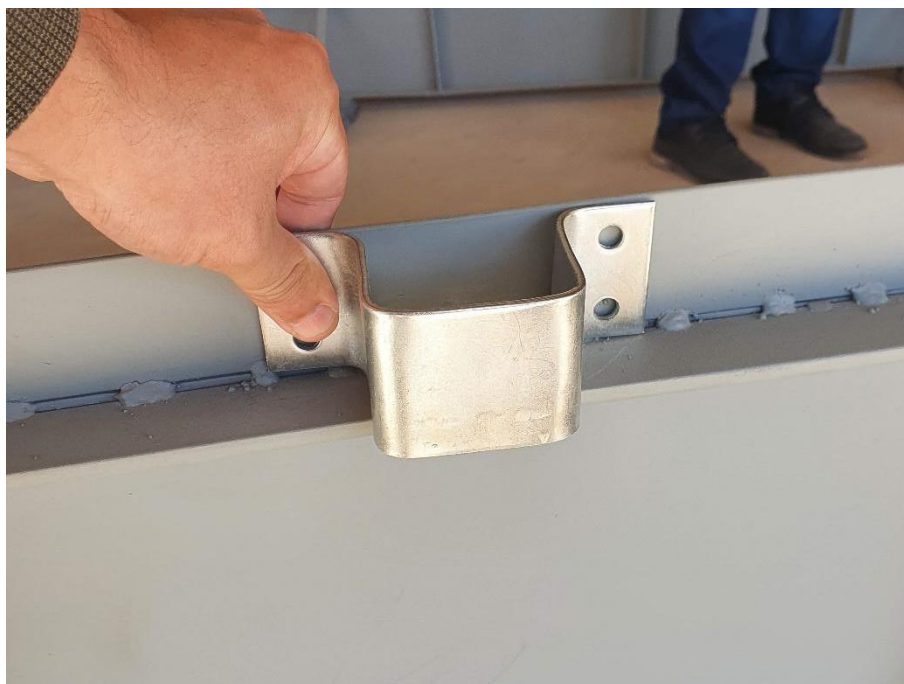
FIGURA 32: Modelo de encaixe do guarda corpo.
