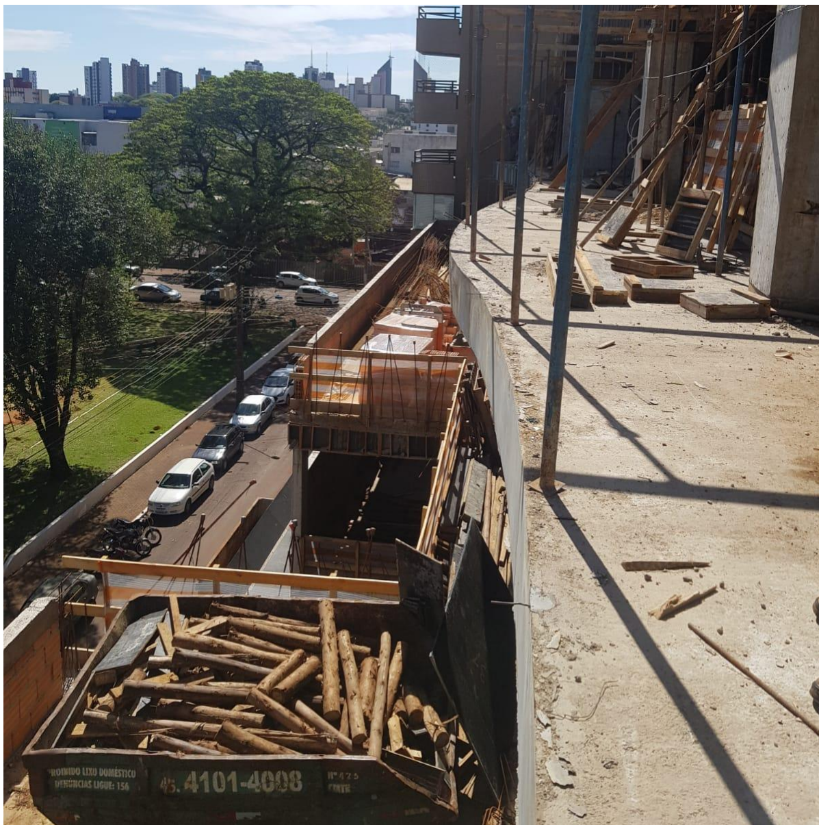
FIGURA 42: Curvatura da viga de concreto armado.
