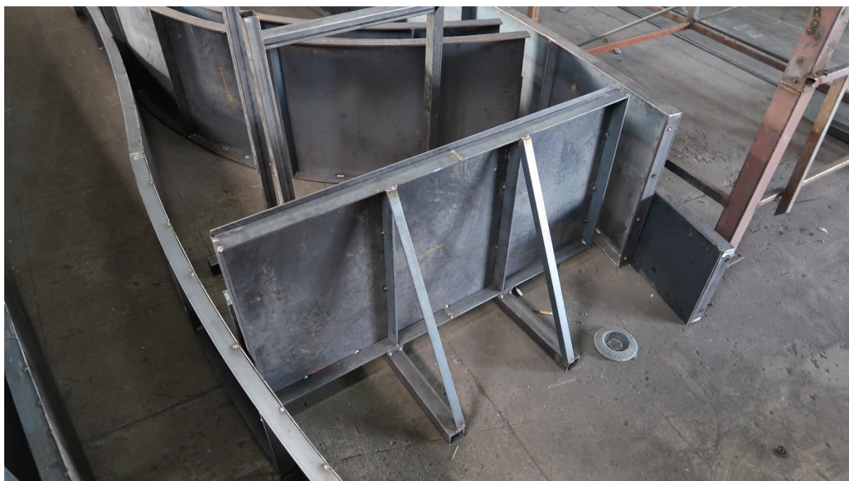
FIGURA 16: Soldagem dos tubos quadrados na fôrma. (Fonte: Autor, 2021).
