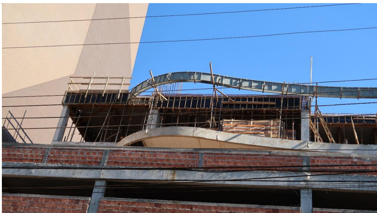
FIGURA 44: Parte esquerda da fôrma fixada no segundo pavimento.
