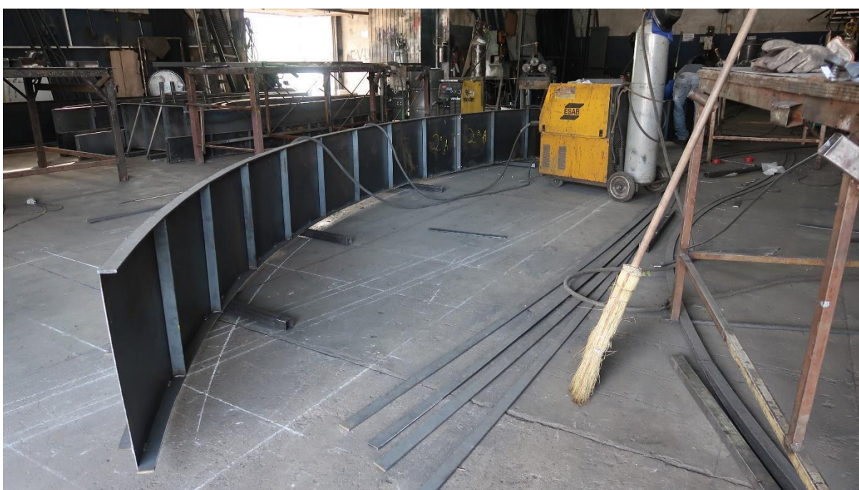
FIGURA 13: Fôrma externa sendo fabricada.
