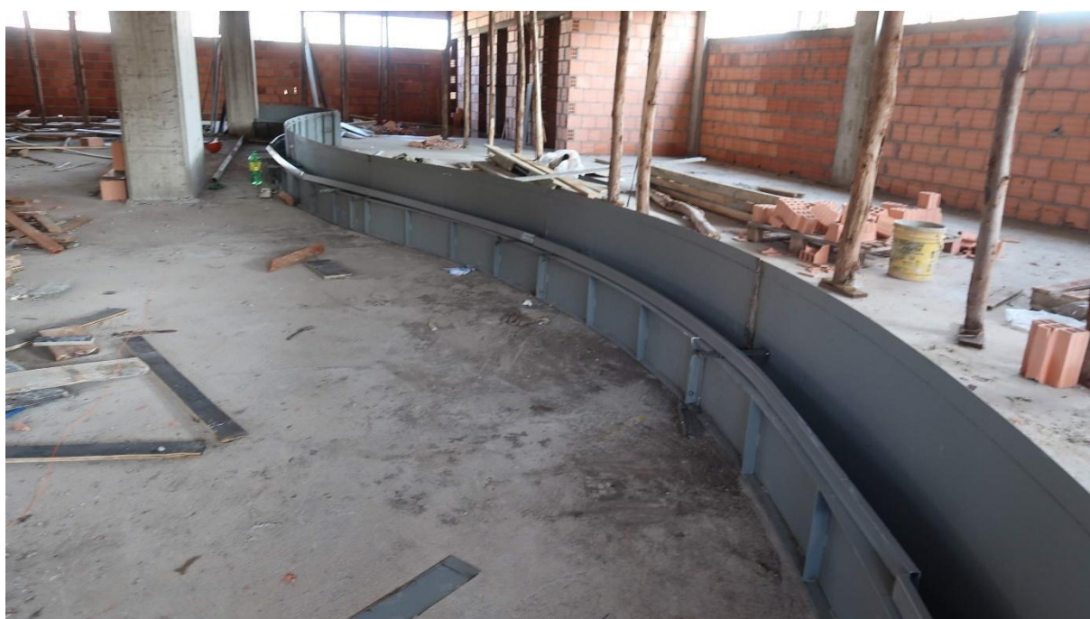
FIGURA 29: Tubos retangulares calandrados.
