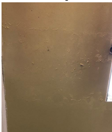
Figura C – Bolhas na pintura do teto
