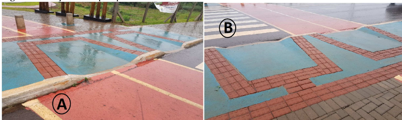
Figura 13: Calçadas com piso podotátil e rebaixamento.
