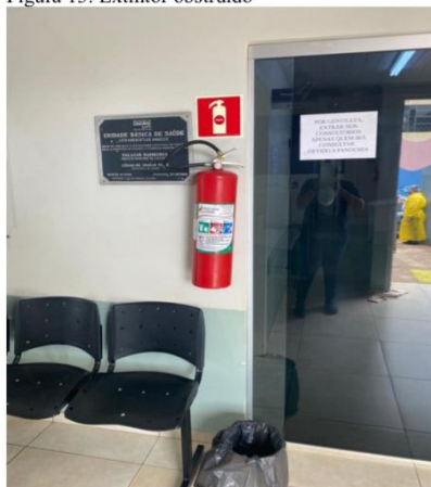
Figura 13: Extintor obstruído
